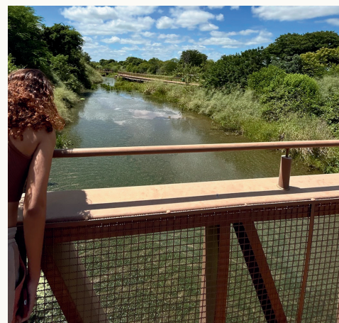
Figura 48: Ponte sobre Canal de Alívio no Vale dos Dinossauros, Sousa-PB Fonte: Acervo Pessoal (2025)
