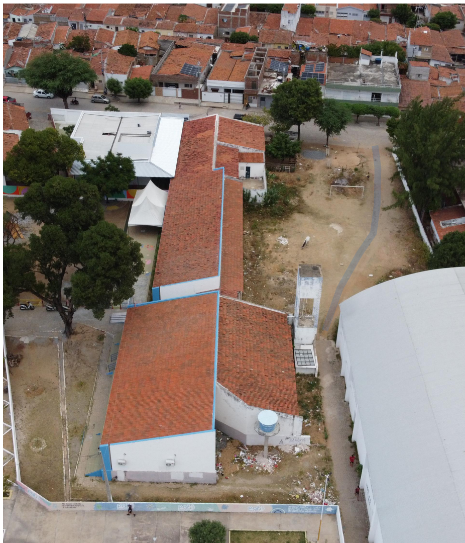
Figura 40: Vista aérea da passagem entre os equipamentos públicos
