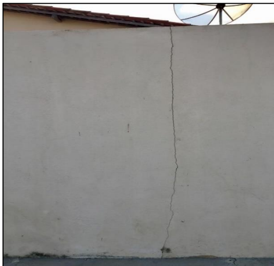
Figura 14 - Fissura no muro da casa do morador da área de 1 km
