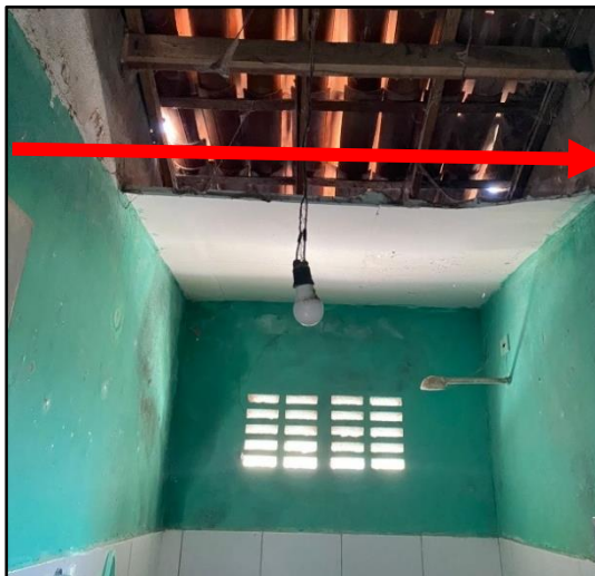
Figura 15 - Desabamento do forro do banheiro morador da área de 1 km
