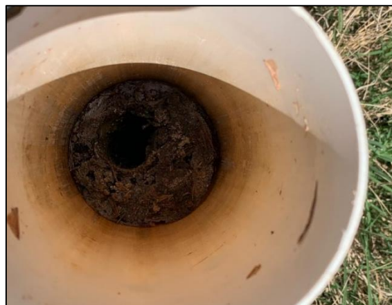
Figura 34. Limpeza da gordura no cano exaustor
