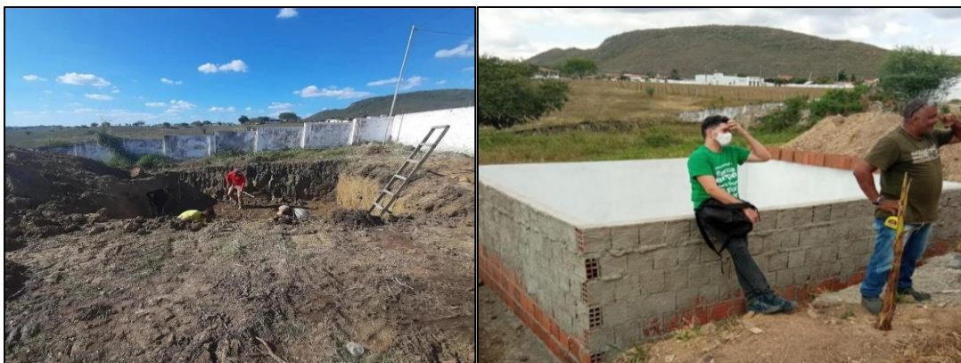
Figura 28. Escavação e a estrutura lateral do TEWetland
