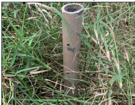
Figura 33. Canos furados para oxigenar o sistema nas camadas superiores
