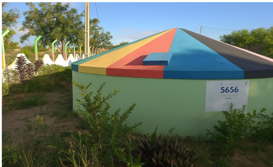
Figura 13 – Cisterna Instalada na Escola Manoel Alves Monteiro
