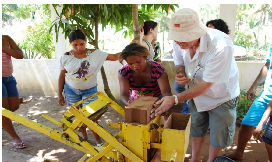
Imagem 16: Construção do Centro Santa Catarina de Siena
