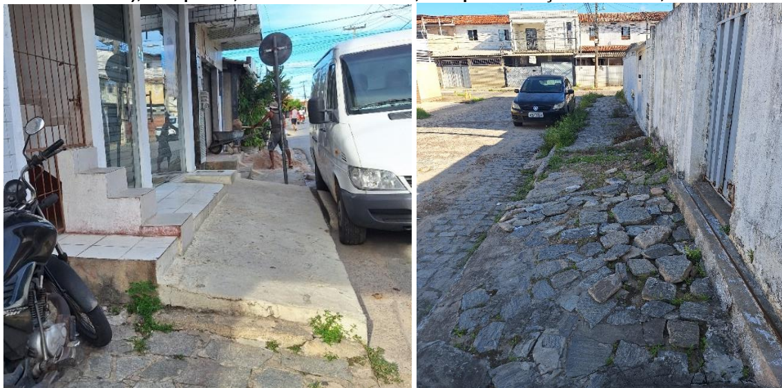
Figura 68 – Visualização da qualidade do pavimento no entorno de uma das comunidades (muitos desníveis), à esquerda, e no interior do bairro, com pavimentação danificada, à direita.
