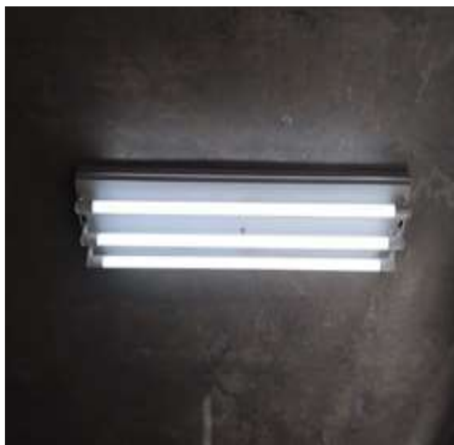
Imagem 6 - Substituição de luminárias convencionais por LED no DNIT/SC.
