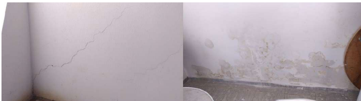
Figura 5 - Manifestações patológicas em habitações do PMCMV - (a) Trincas nos muros (b) Eflorescência
