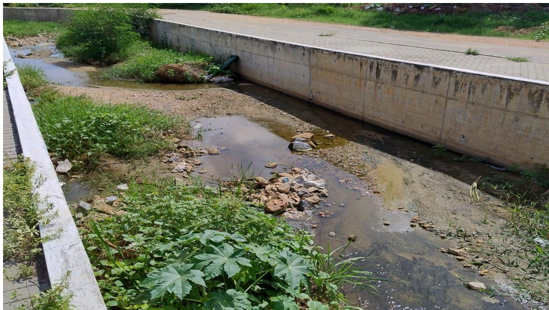
Figura 14 – Alteração do Canal de drenagem (Canal do Frango) devido à presença e crescimento de vegetação no sistema de drenagem em Patos (PB)
