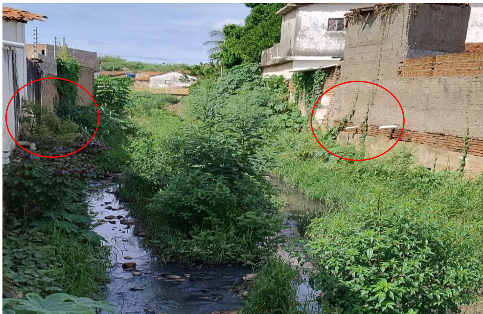
Figura 15 – Lançamento de águas residuais por redes clandestinas no canal de drenagem na zona Norte em Patos (PB)
