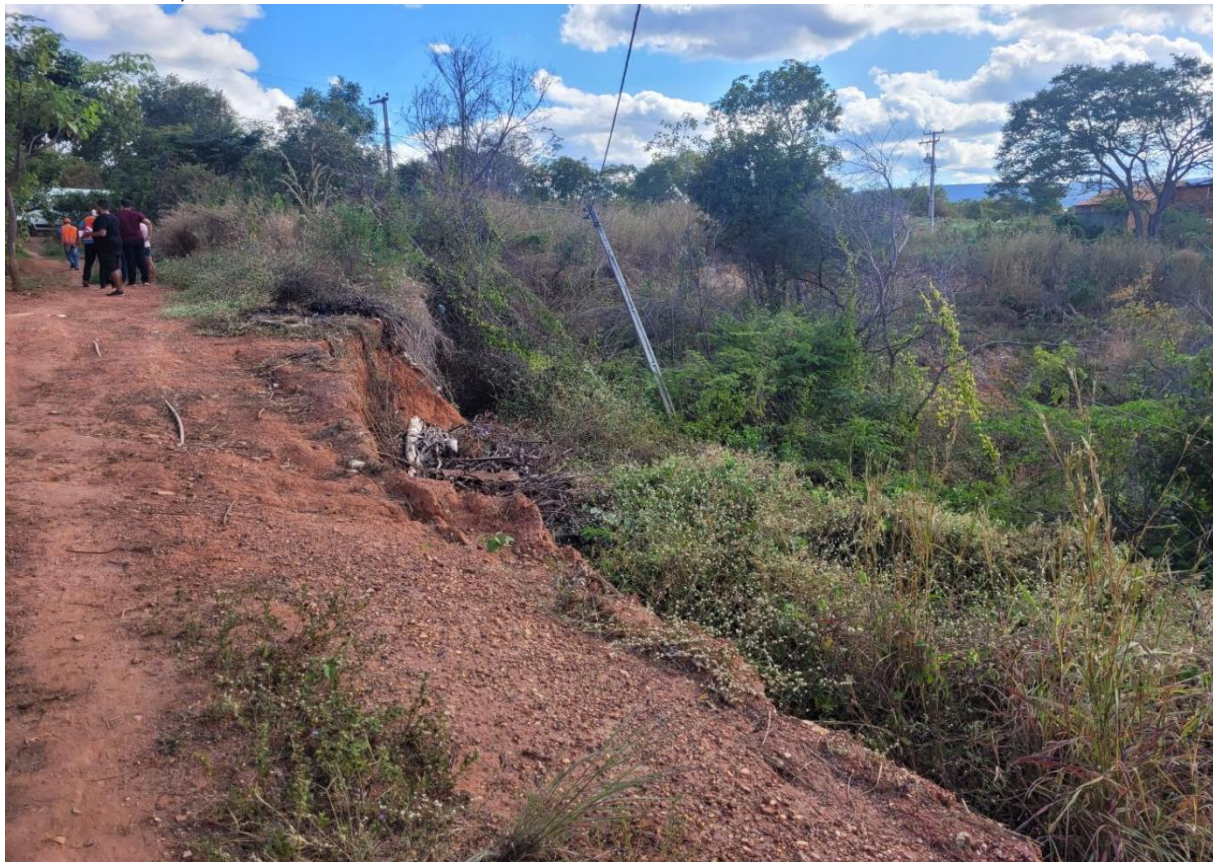
Fotografia 25 - Postes com fiação de energia elétrica “sugados” pela voçoroca na área de risco Vale do Amanhecer, em Crato
