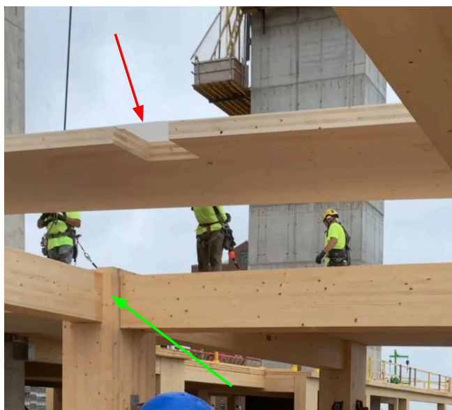
Figura 25 - Exemplos de corte (seta vermelha) no painel de MLCC de uma laje sendo içada para encaixe em um pilar (seta verde)
