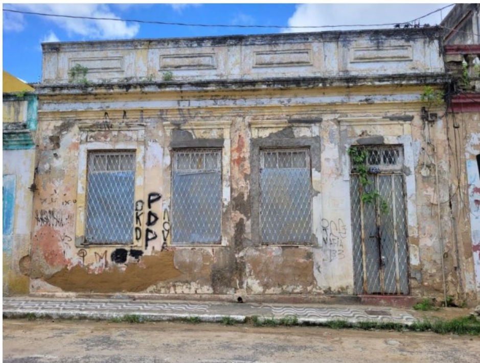
Figura 1– Local de fundação do conjunto
