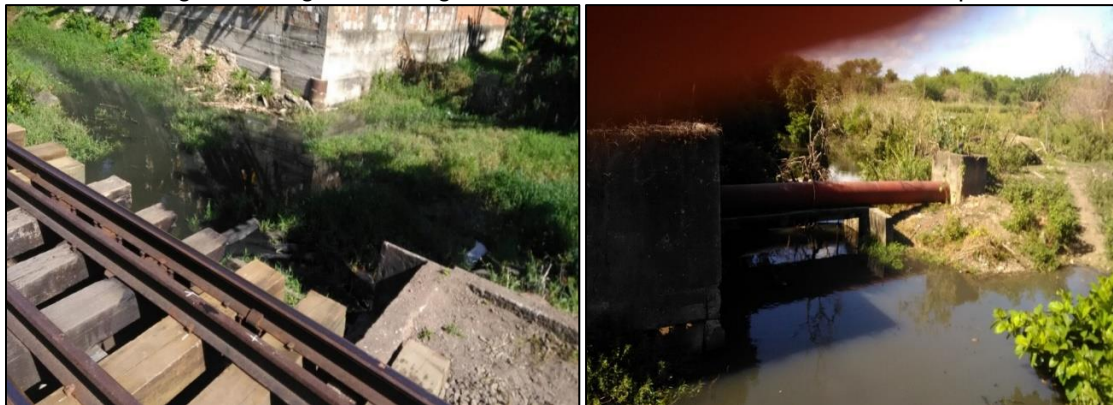
Figura 15. Água com esgoto doméstico na comunidade Porto do Capim.
