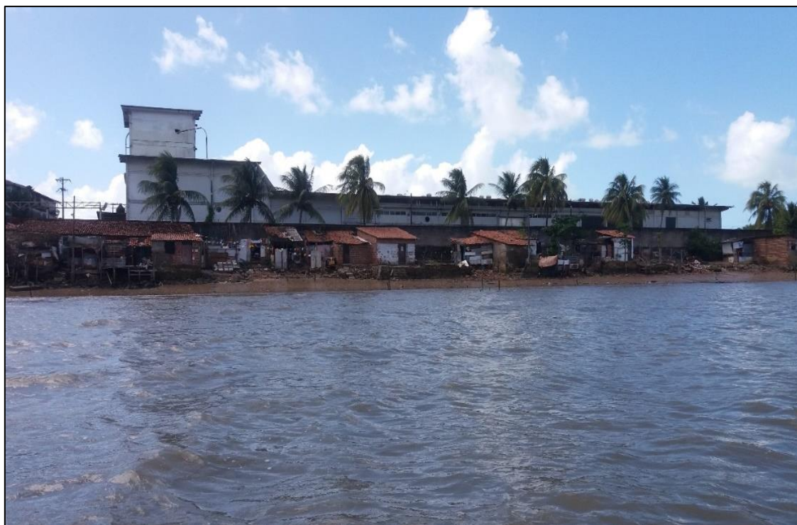
Figura 7. Construções irregulares na faixa de praia no Estuário do Rio Paraíba, Cabedelo.
