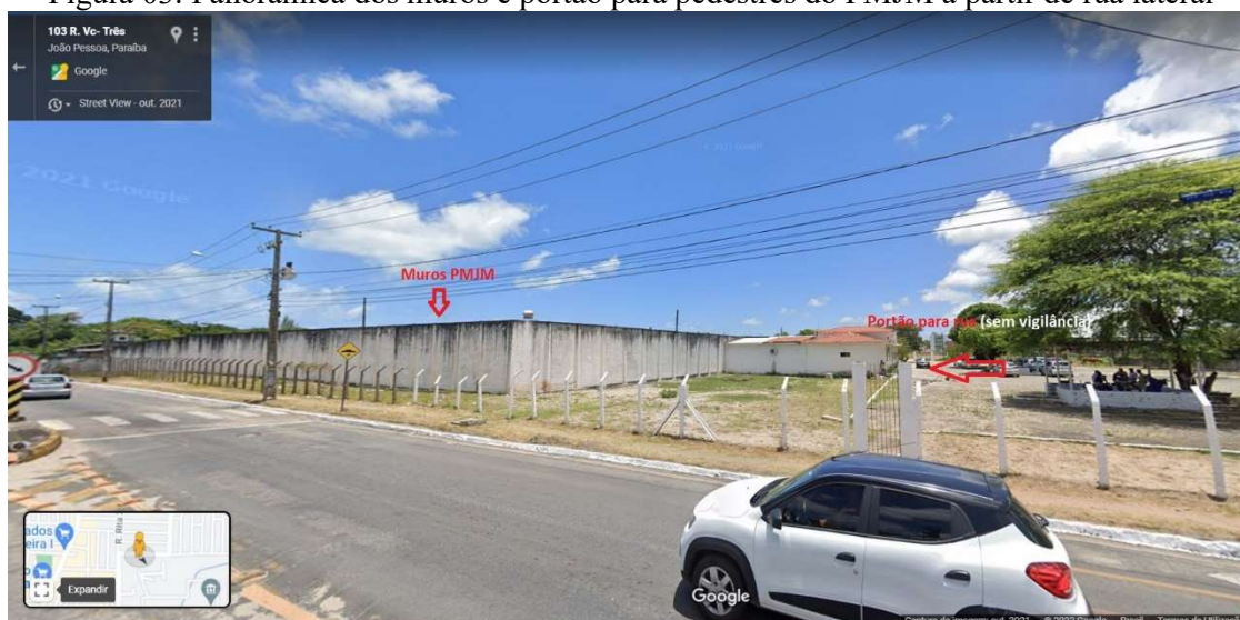
Figura 03: Panorâmica dos muros e portão para pedestres do PMJM a partir de rua lateral
