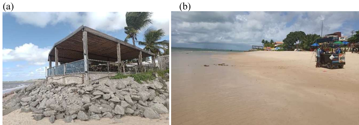
Figura 43. (a) Obra na Praia do Seixas que vem barrando o transporte de sedimentos, acarretando uma sedimentação na direção norte em julho de 2025, e (b) vista do processo de acumulação de sedimentos ao norte da obra em março de 2024.
