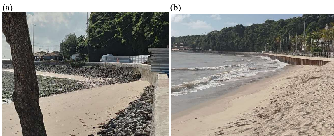
Figura 42. (a) Vista parcial do setor localizado entre as obras do enrocamento do Mirante na praia do Cabo Branco onde verifica-se uma perda de sedimentos, e (b) área com presença de acúmulo de sedimentos advindos do setor onde ocorre a perda de sedimentos (Figura 42a), devido a reflexão das ondas ao atingirem o muro do Mirante em março de 2024.
