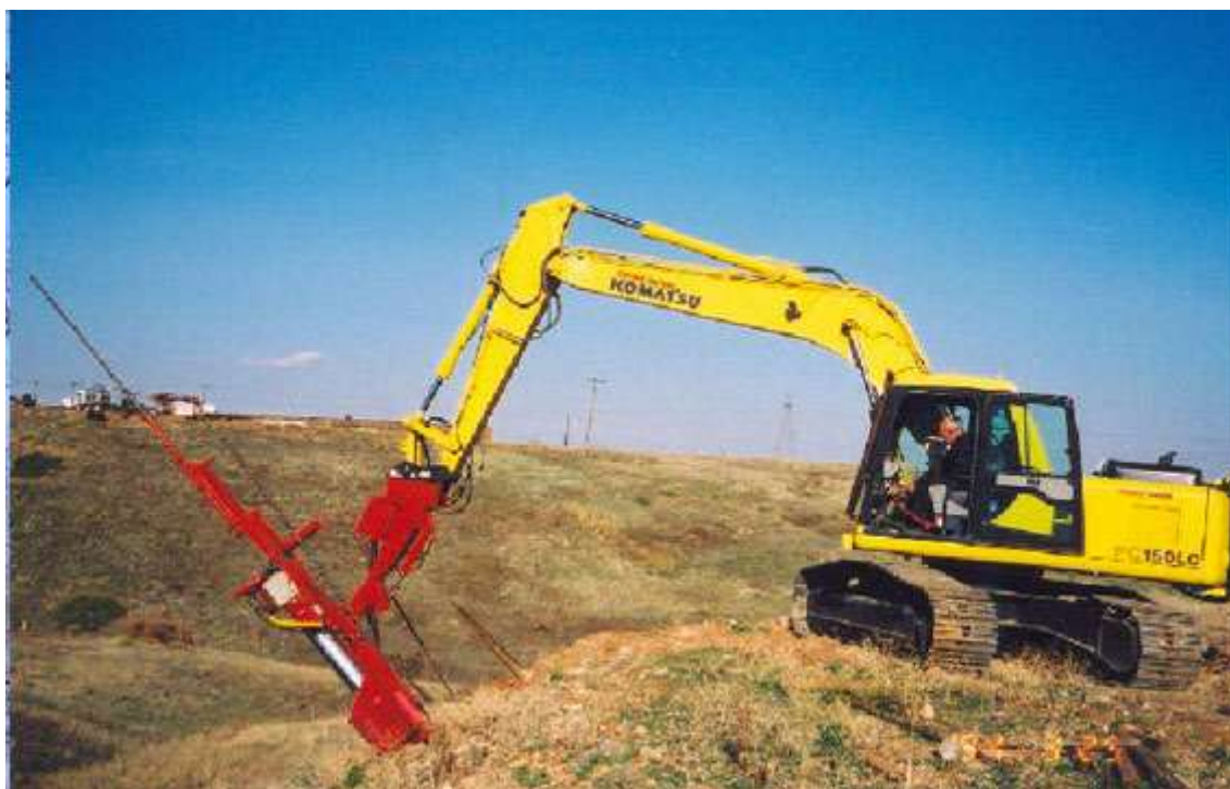
Figura 14: Execução da cravação de grampos
