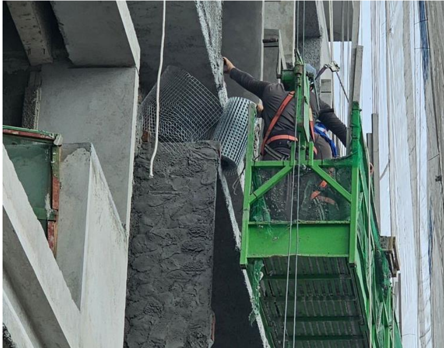
Figura 4 - Execução do reboco.
