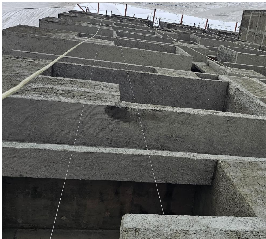
Figura 3 - Prumadas de arame para mapeamento da fachada.
