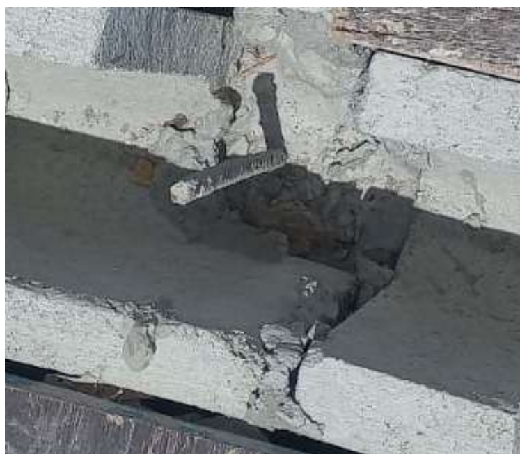
Figura 11: Célula do bloco grauteada
