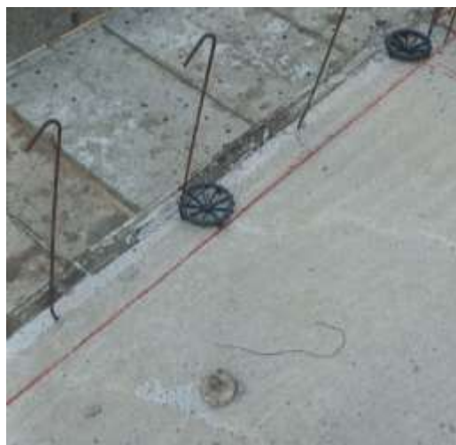
Figura 15: Marcação da laje
