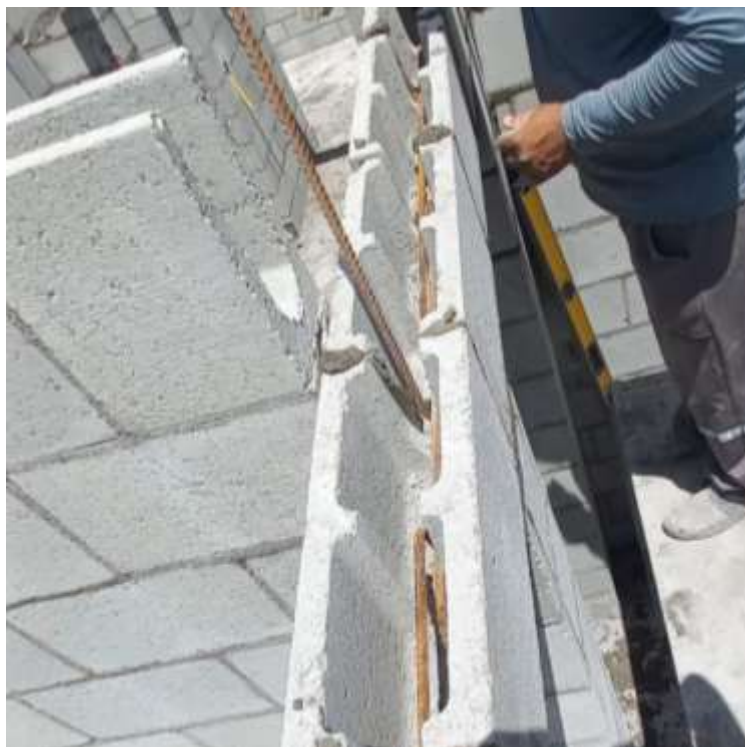
Figura 10: Canaleta tipo “U” sendo grauteada para formar verga da porta
