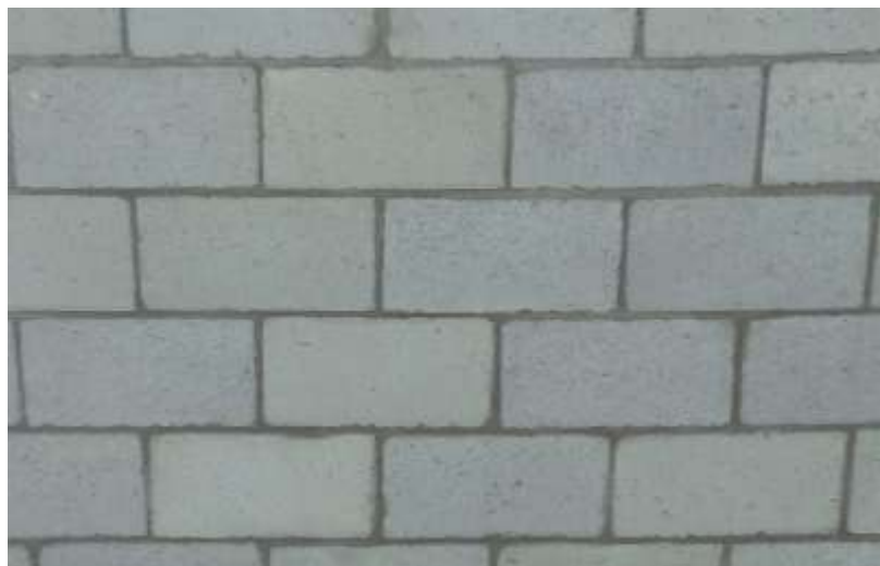
Figura 6: Junta de argamassa
