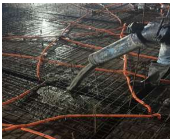
Figura 18: Lançamento do concreto
