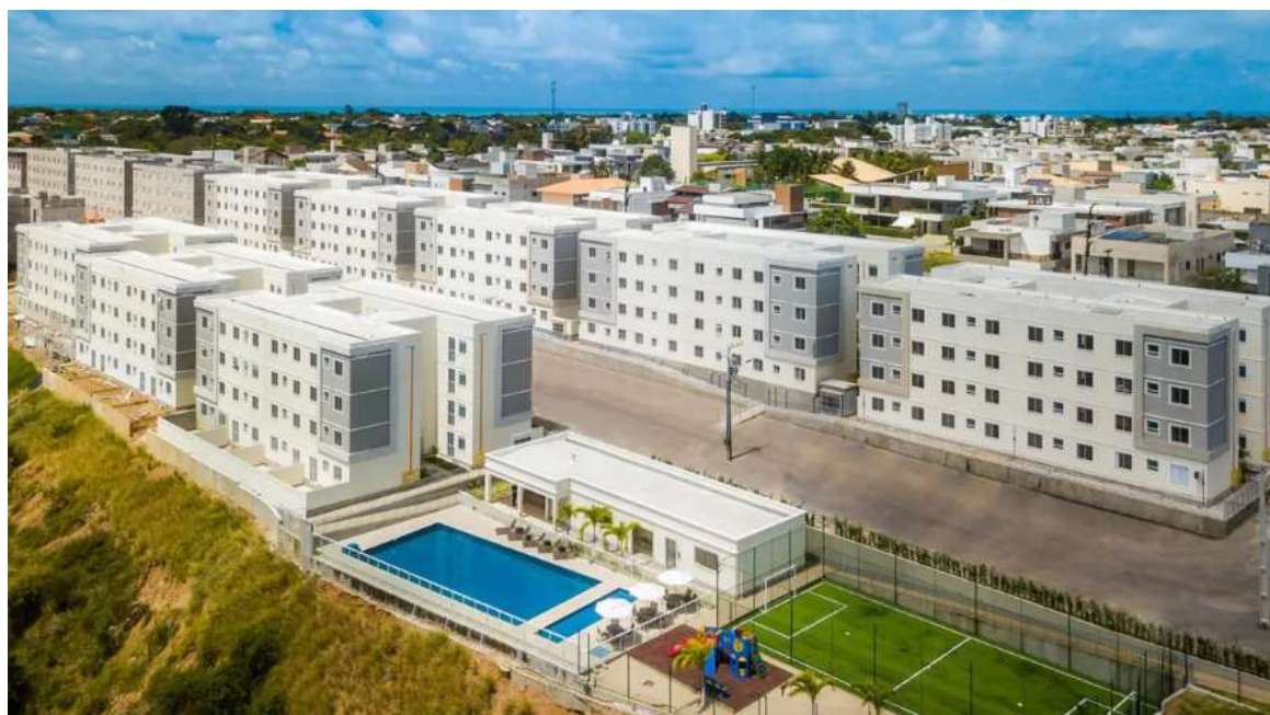
Figura 20: Obra executada com parede de concreto
