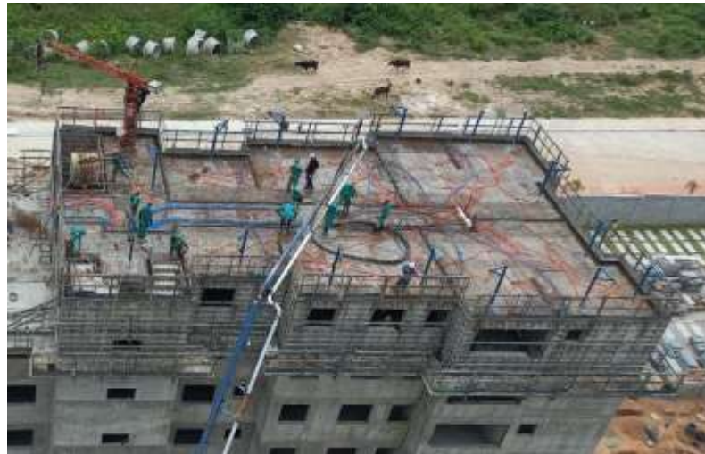
Figura 17: Montagem das fôrmas
