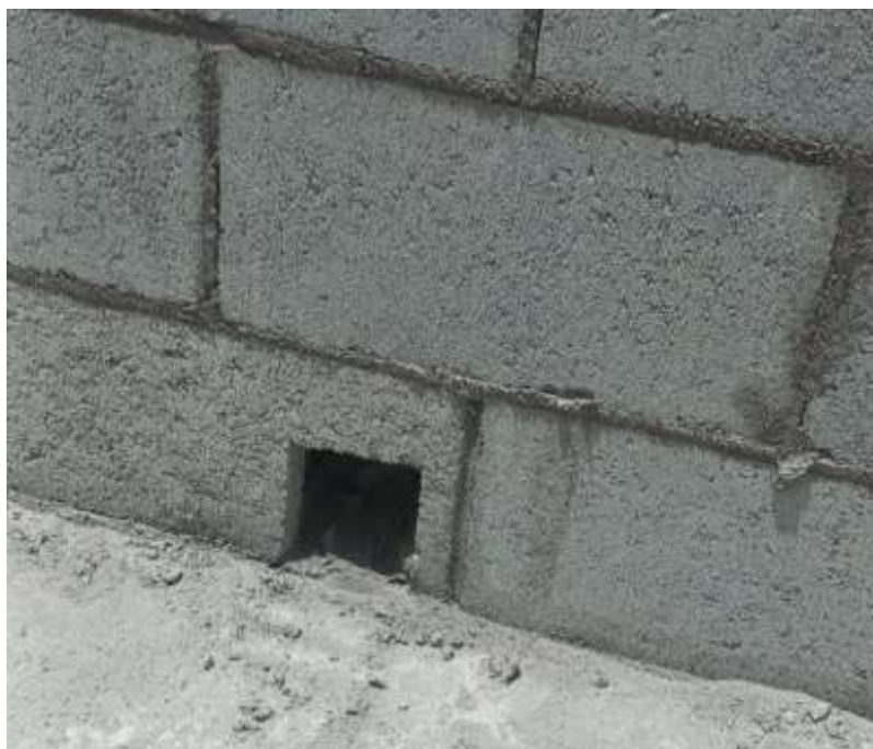
Figura 9: Acesso de limpeza
