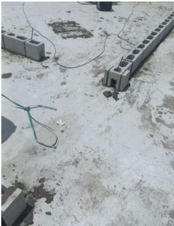
Figura 8: Demarcação da primeira fiada de blocos
