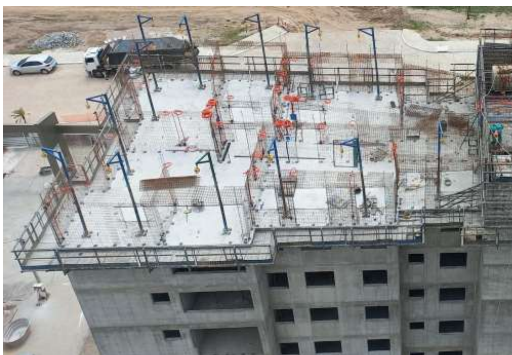
Figura 16: Montagem da armação
