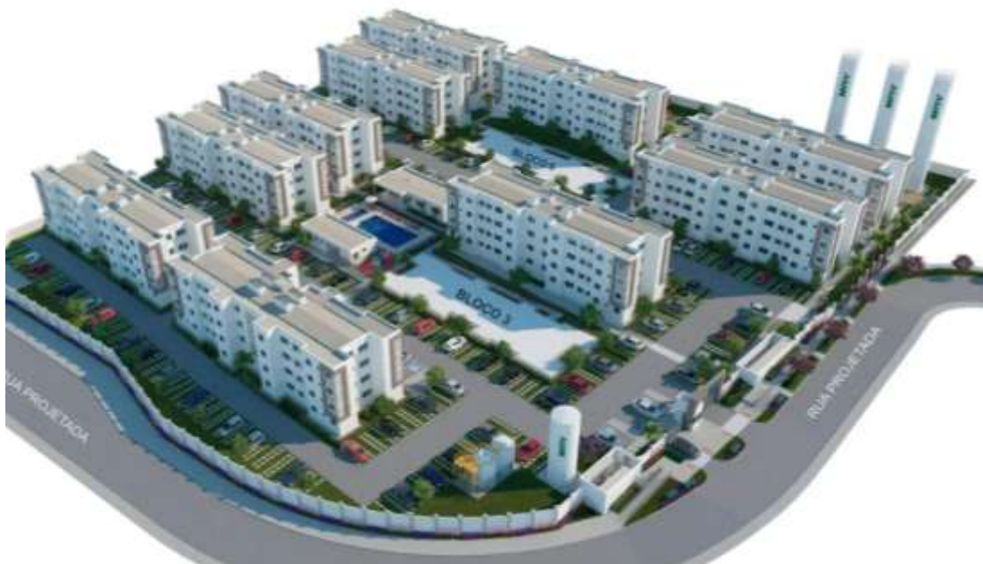
Figura 21: Obra executada com alvenaria estrutural
