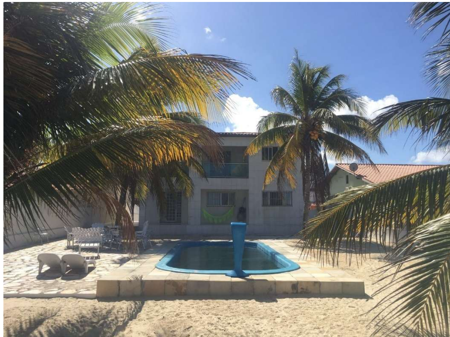
Figura 15: Fachada Leste da edificação
