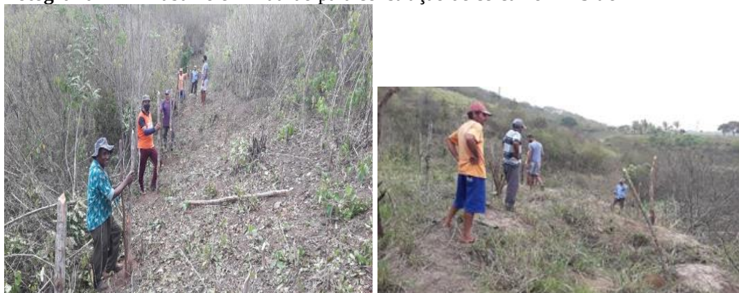
Fotografia 27 – Trabalho em mutirão para construção de cerca no PA Sítio
