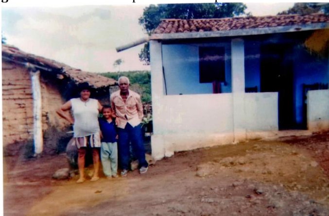
Fotografia 38 – Casa de taipa substituída por uma casa de alvenaria
