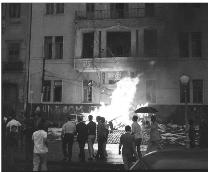
Imagem 01 - Prédio da UNE incendiado (1964)
