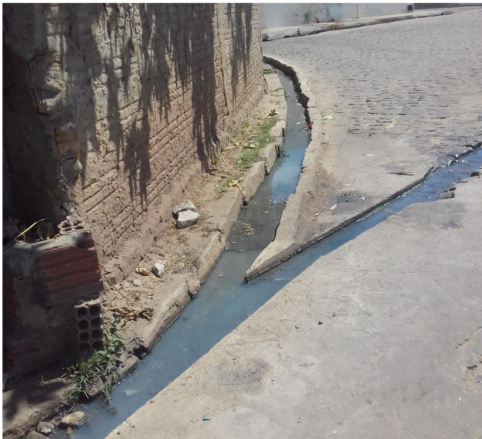
Figura 15- Canal por onde a água residual das atividades domésticas (água cinza) é despejada na rua e segue em direção ao mar.
