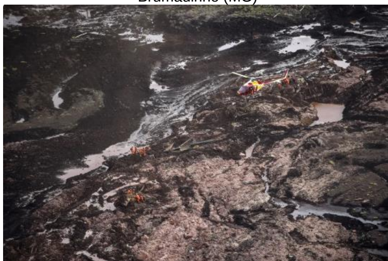
Figura 4 – Vista do desastre da barragem B1 em Brumadinho (MG)
