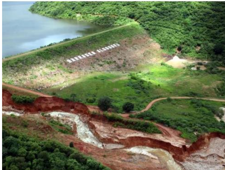
Figura 1 – Rompimento da barragem de Algodões (PI) em 2009
