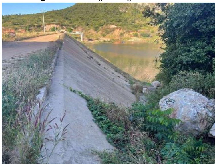
Figura 15 - Barragem Engenheiro Ávidos
