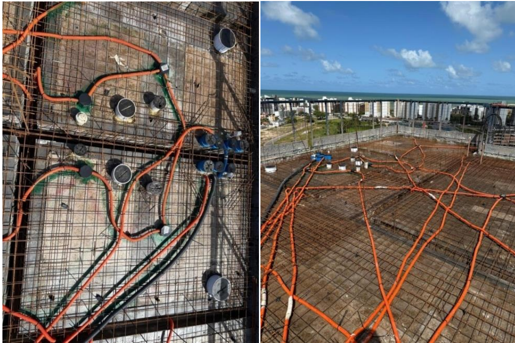
Figura 43 – Instalações Embutidas na Laje
