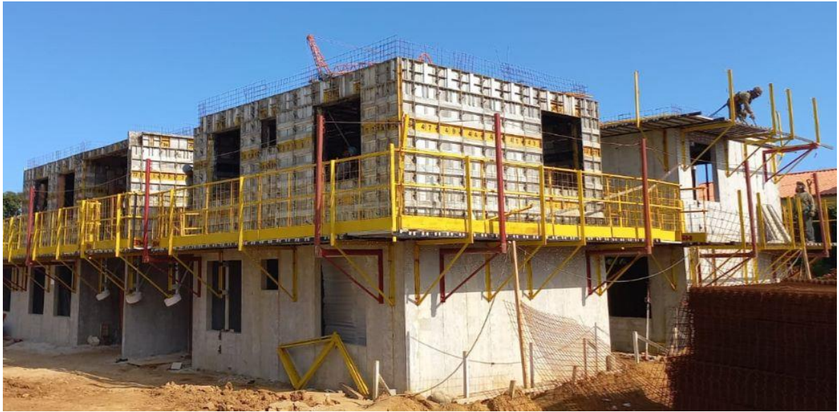
Figura 01 – Edifício de Paredes de Concreto
