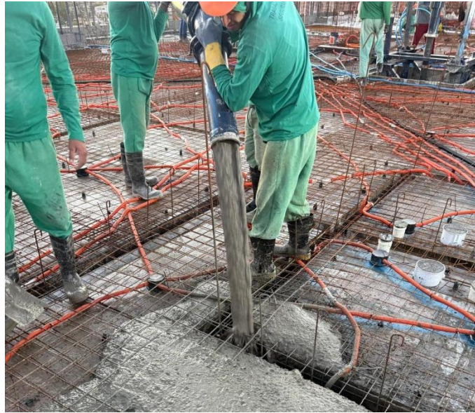
Figura 48 – Etapa de Concretagem
