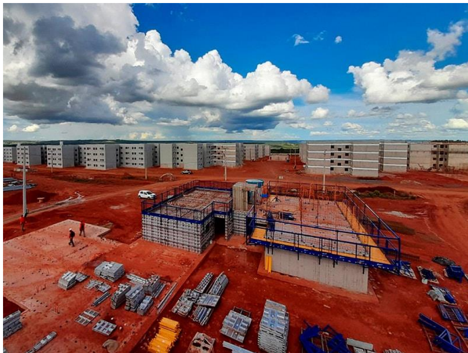
Figura 26 – Canteiro de Obras com Paredes de Concreto
