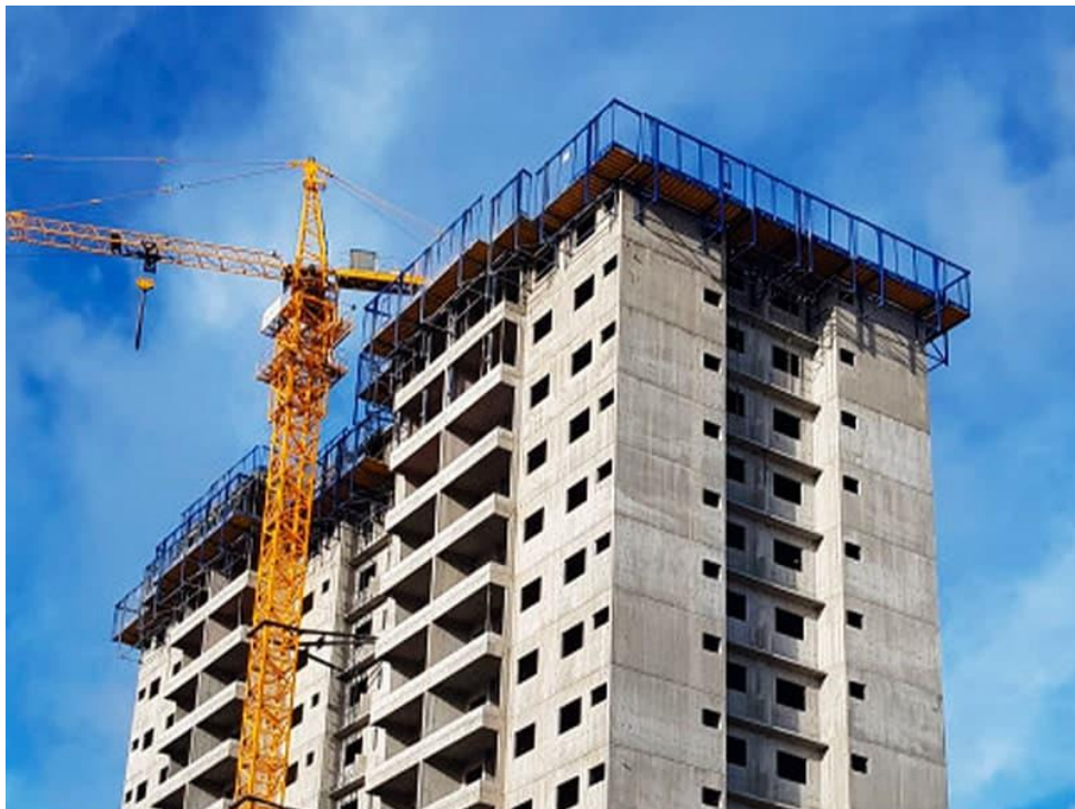
Figura 33 – Sistema Gang com Andaimes Trepantes
