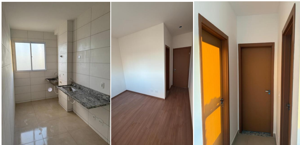
Figura 56 – Acabamento Final de uma Obra de Parede de Concreto
