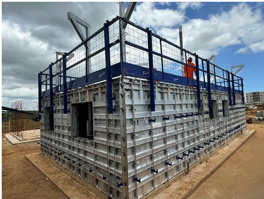
Figura 08 – Fôrmas Metálicas
