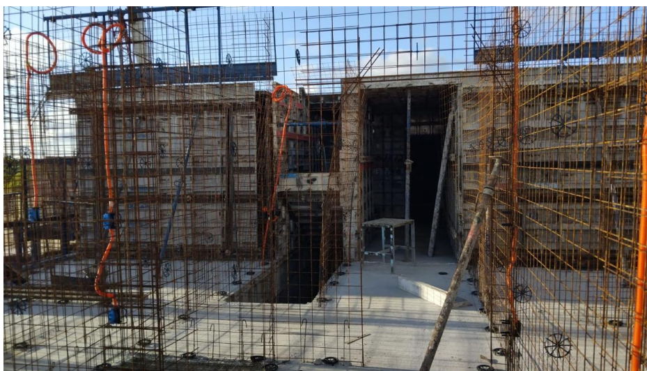
Figura 40 – Pavimento na Fase de Estrutura de Parede de Concreto
