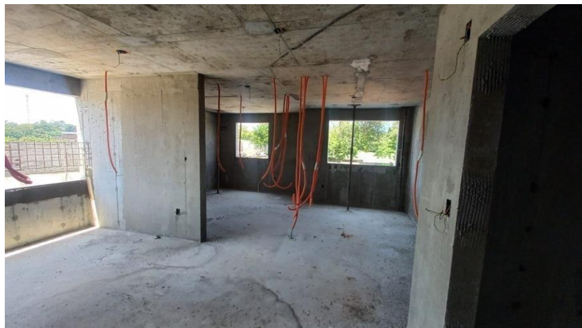
Figura 54 – Produto Final da Parede de Concreto
