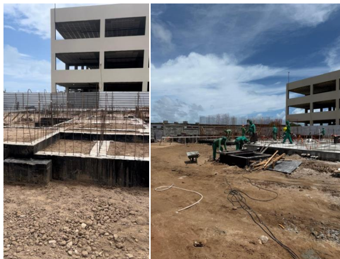
Figura 29 – Modelo de Fundação para Paredes de Concreto
