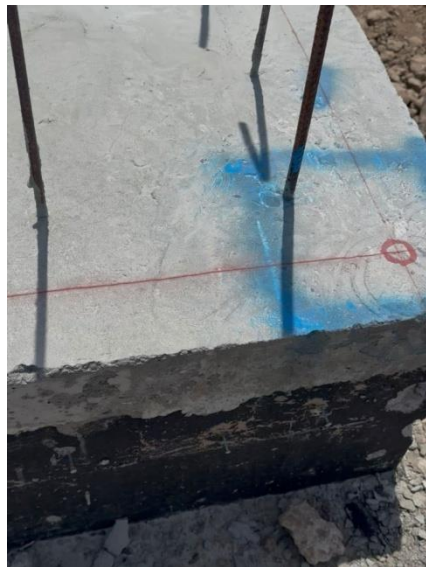
Figura 31 – Marcação das Paredes
