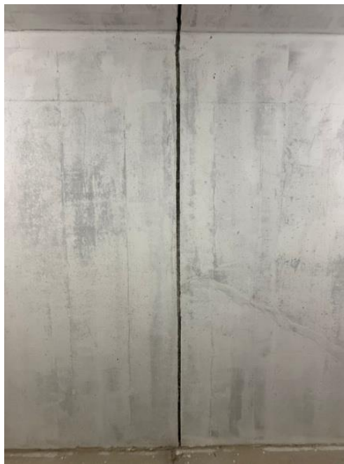
Figura 11 – Junta de Dilatação
