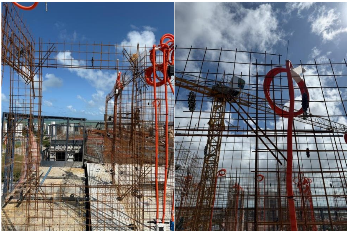
Figura 35 – Montagem de Armação para Parede de Concreto
