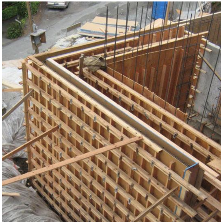
Figura 06 – Fôrmas de Madeira
