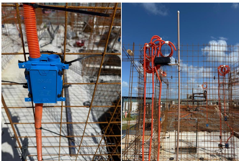
Figura 37 – Instalações Elétricas e Hidráulicas Fixadas na Armação
