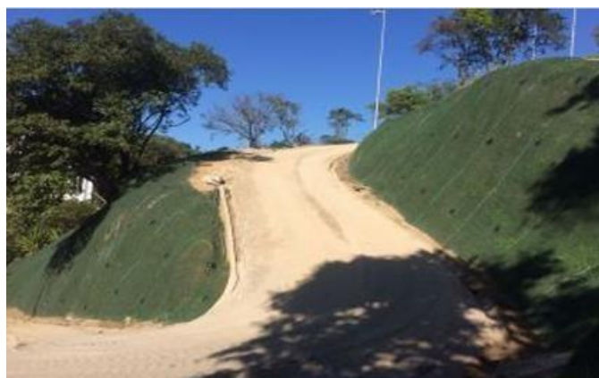
Figura 14 - Depois da Obra
