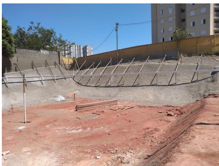
Figura 12 - Finalização da face de concreto projetado
