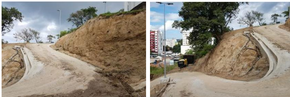
Figura 13 - Antes da Obra
