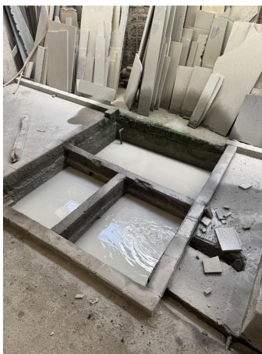
Figura 2: Tanque de Decantação do resíduo
