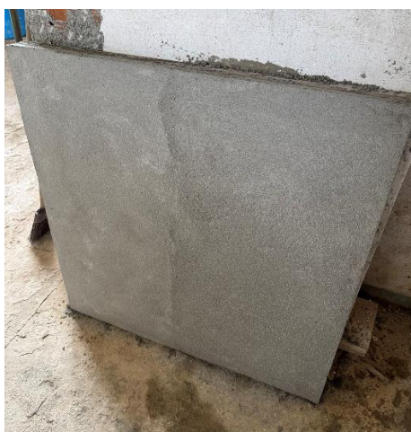
Figura 17: Argamassa aplicada sob placa de concreto
