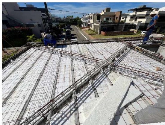
Figura 72: Laje da garagem com vigamento semi-invertido.
