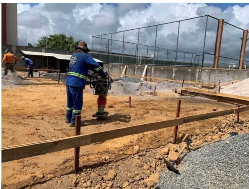
Figura 40: Execução de gabarito e compactação do melhoramento de solo.
