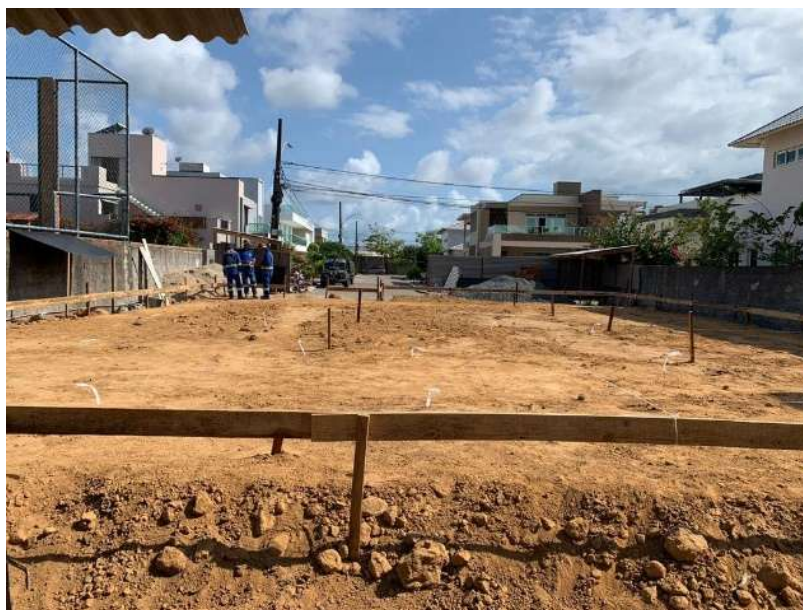
Figura 7: Gabarito da obra
