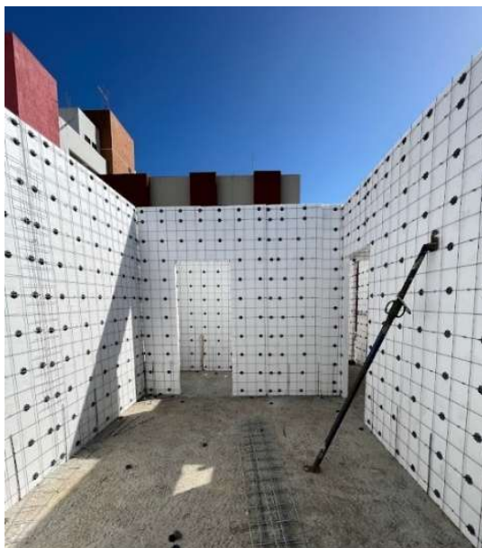
Figura 52: Fixação dos painéis nas barras de ancoragem.
