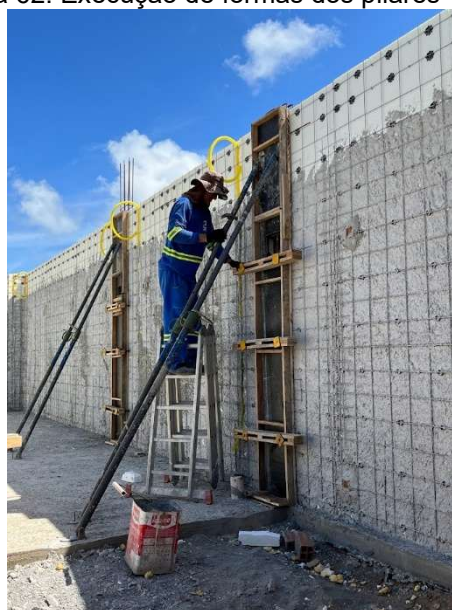
Figura 62: Execução de formas dos pilares
