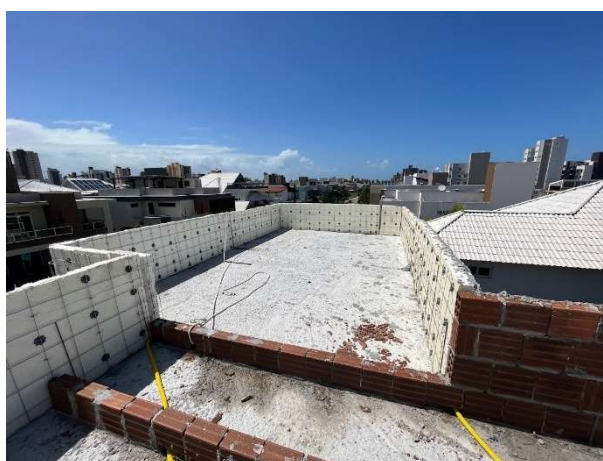
Figura 86: Platibanda executada em Painéis Monolíticos em EPS.
