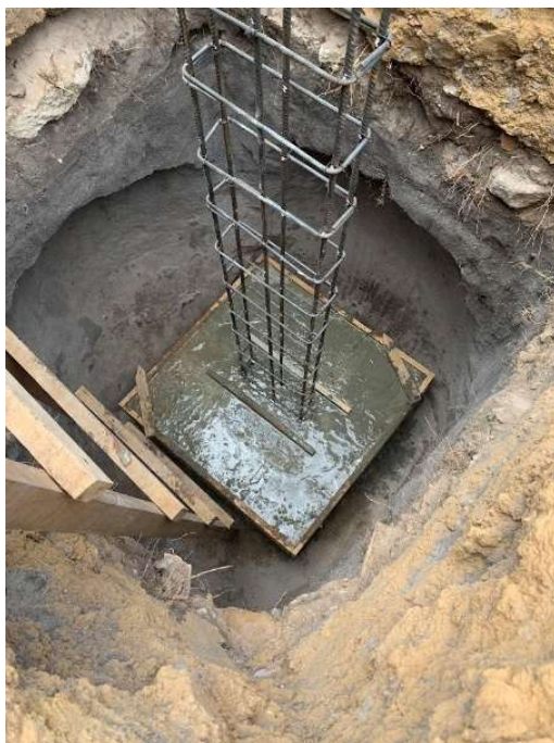
Figura 42: Concretagem das sapatas.
