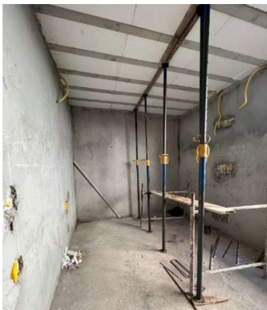
Figura 70: Quarto com 1 faixa de escoramento.
