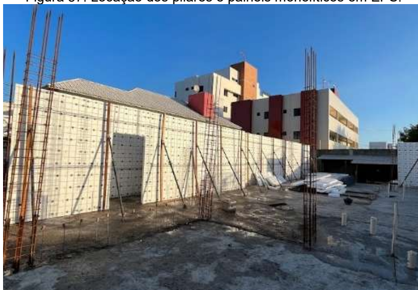
Figura 57: Locação dos pilares e painéis monolíticos em EPS.
