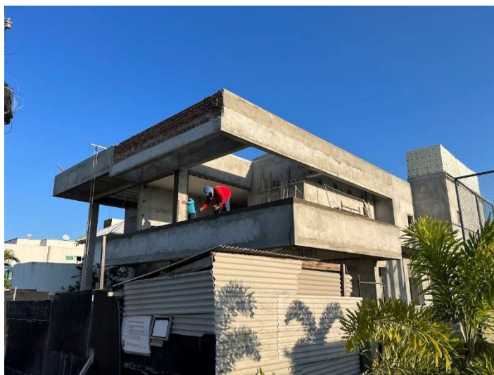
Figura 85: Ajustes na fachada feitos com alvenaria.
