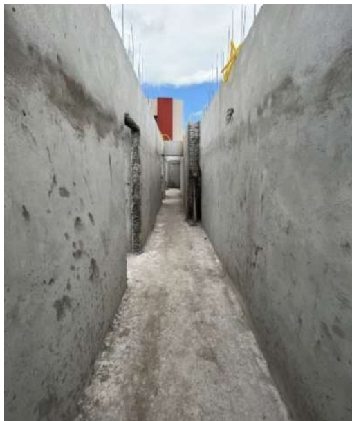
Figura 66: Reboco do corredor concluído e curado.
