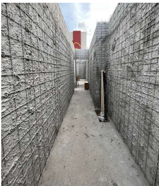
Figura 65: Etapa de chapisco do corredor concluída
