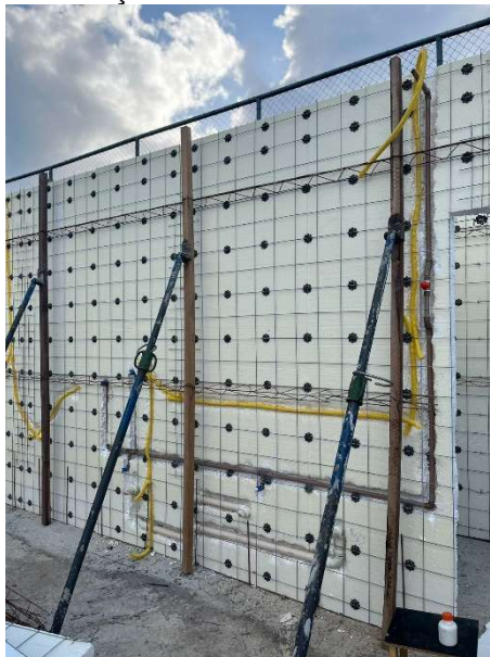
Figura 58: instalações elétricas e hidráulicas embutidas.
