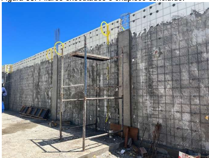
Figura 63: Pilares executados e chapisco concluído.
