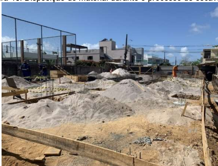
Figura 46: Disposição do material durante o processo de escavação.
