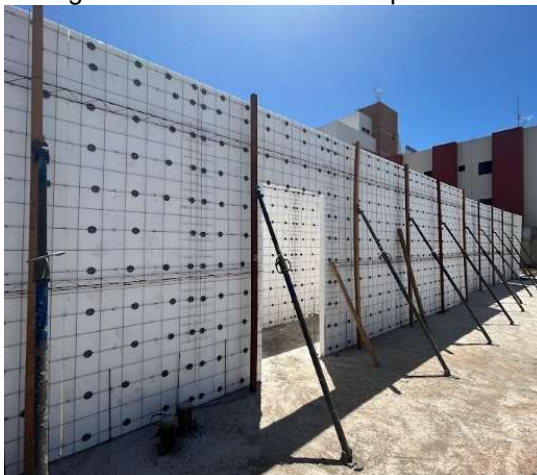
Figura 55: Parede locada e aprumada.
