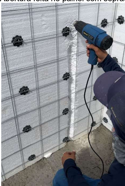
Figura 59: Abertura feita no painel com soprador térmico.
