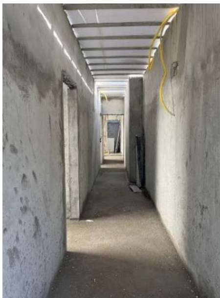
Figura 69: Corredor sem necessidade de escoramento.
