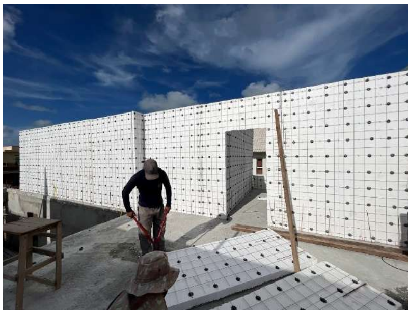
Figura 76: Locação dos painéis do primeiro pavimento.
