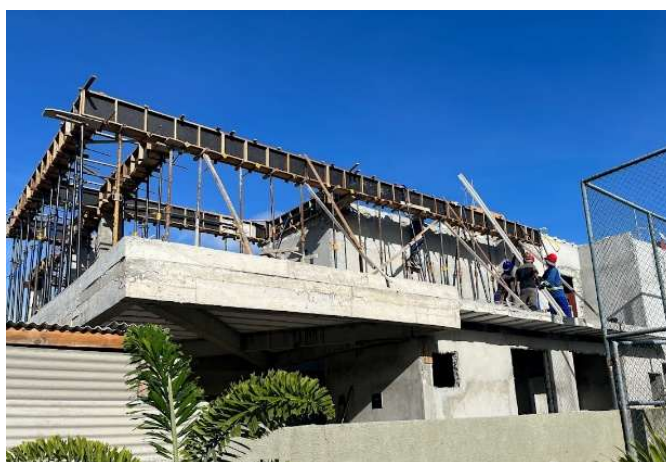
Figura 79: Forma das vigas da fachada norte e oeste.
