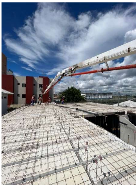
Figura 75: Concretagem da Laje do primeiro térreo.
