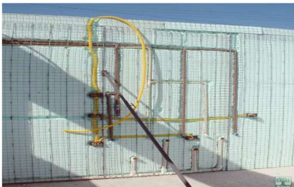
Figura 22 - Instalações elétricas e hidráulicas em EPS
