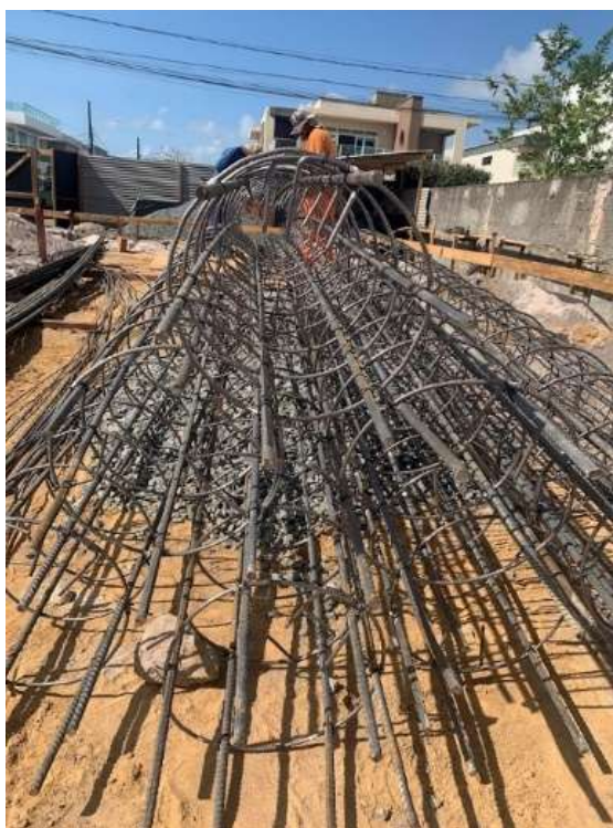
Figura 41: Aço das fundações cortado e dobrado in loco.
