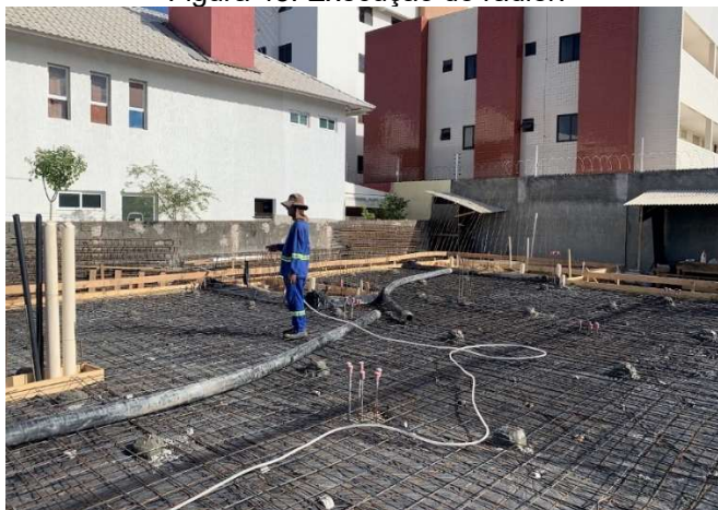
Figura 48: Execução do radier.
