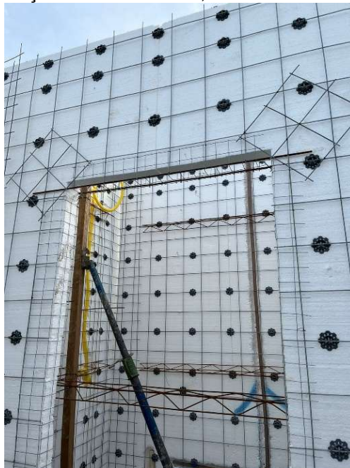
Figura 57: Locação dos pilares e painéis monolíticos em EPS.
