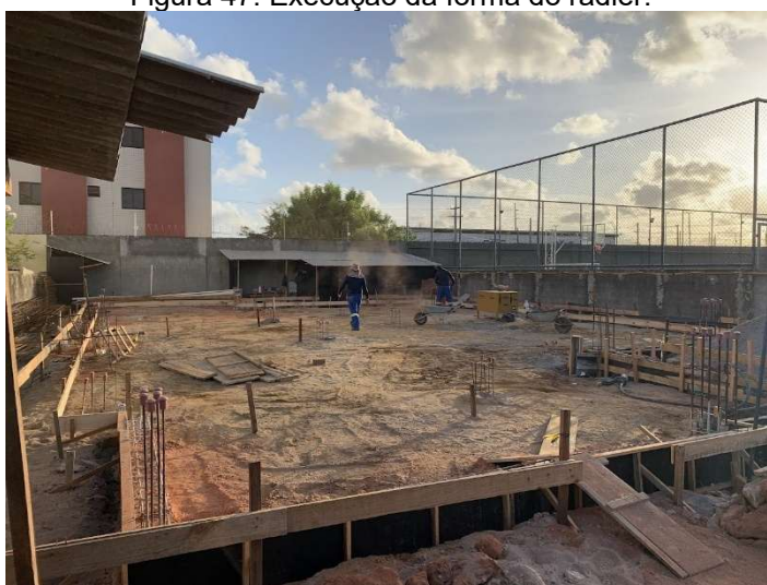
Figura 47: Execução da forma do radier.
