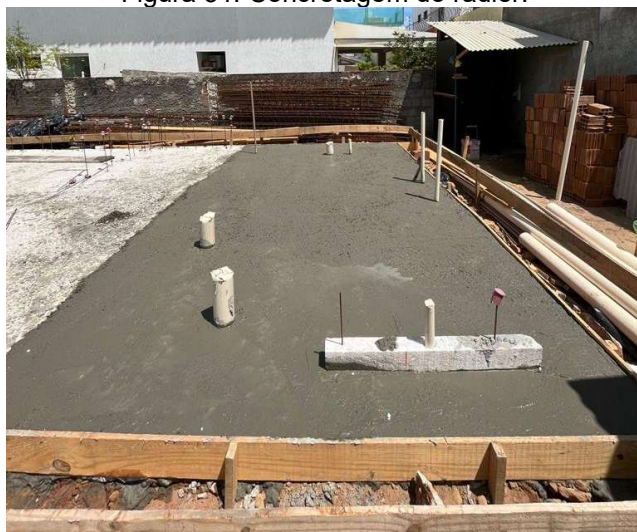
Figura 51: Concretagem do radier.
