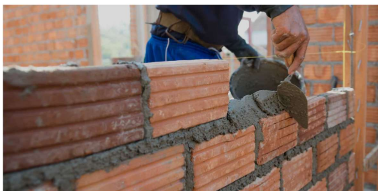
Figura 2: Assentamento de bloco cerâmico
