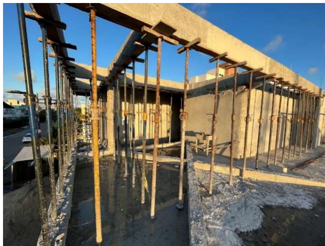
Figura 81: Vigas das fachadas norte e oeste concluídas.
