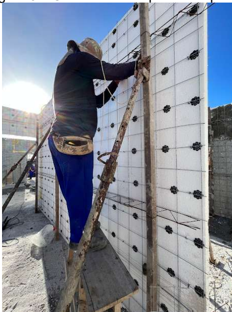
Figura 55: Parede locada e aprumada.
