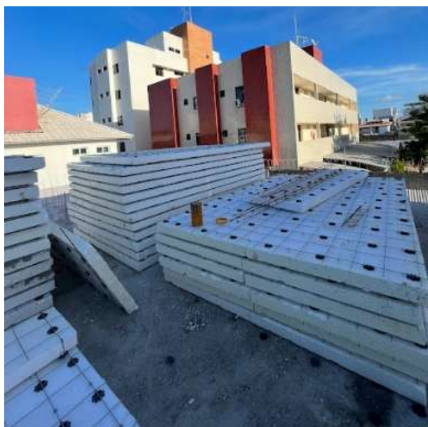
Figura 11: Painéis monolíticos recebidos na obra.
