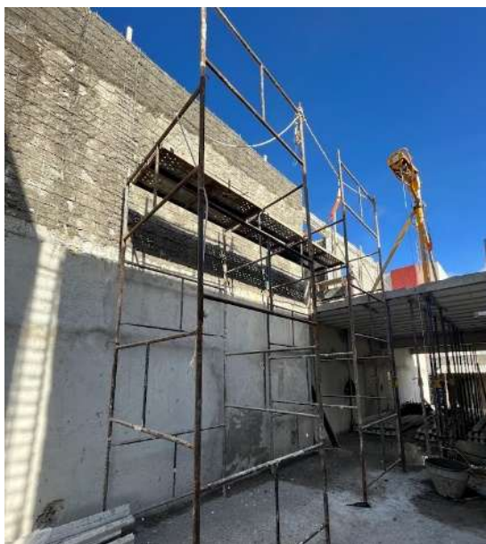
Figura 77: Execução de chapisco e reboco das paredes de pé direito duplo do primeiro pavimento.
