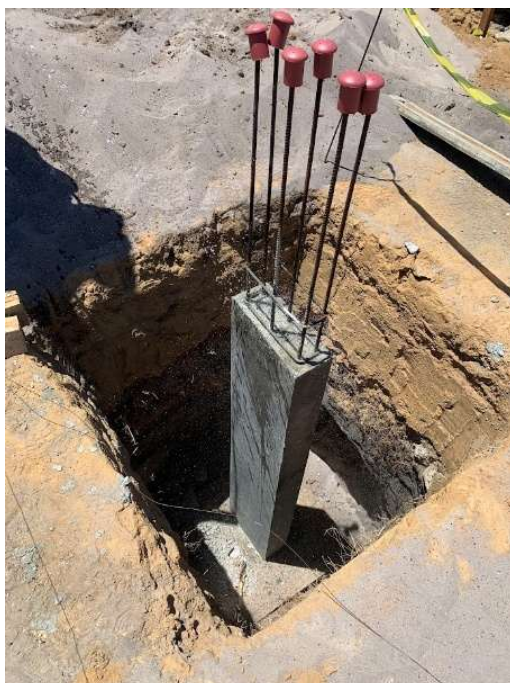
Figura 43: Concretagem dos arranques dos pilares.
