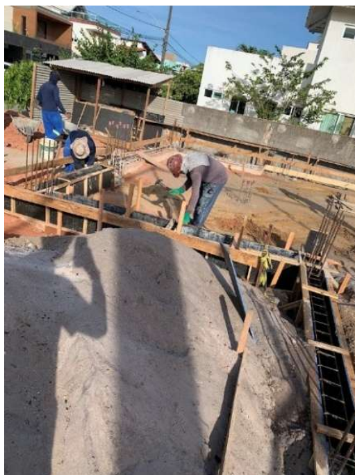
Figura 44: Concretagem das vigas baldrame.
