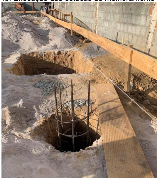
Figura 45: Execução das estacas de melhoria de solo.
