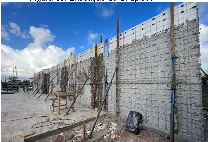
Figura 60: Execução de Chapisco
