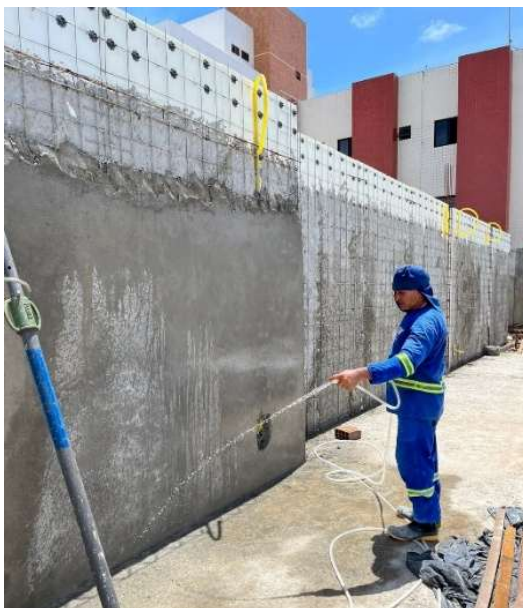
Figura 64: Processo de cura úmida do reboco estrutural
