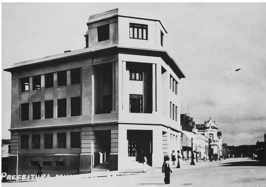
Edifício da Prefeitura municipal de Campina Grande, av. Mal. Floriano Peixoto. 56. Registro fotográfico da execução de sua estrutura independente em concreto armado. Fonte: Jornal A União, 21 set. 1941. 57. Obra concluída no começo da década de 1940. Fonte: Arquivo pessoal Severino Cabral.
