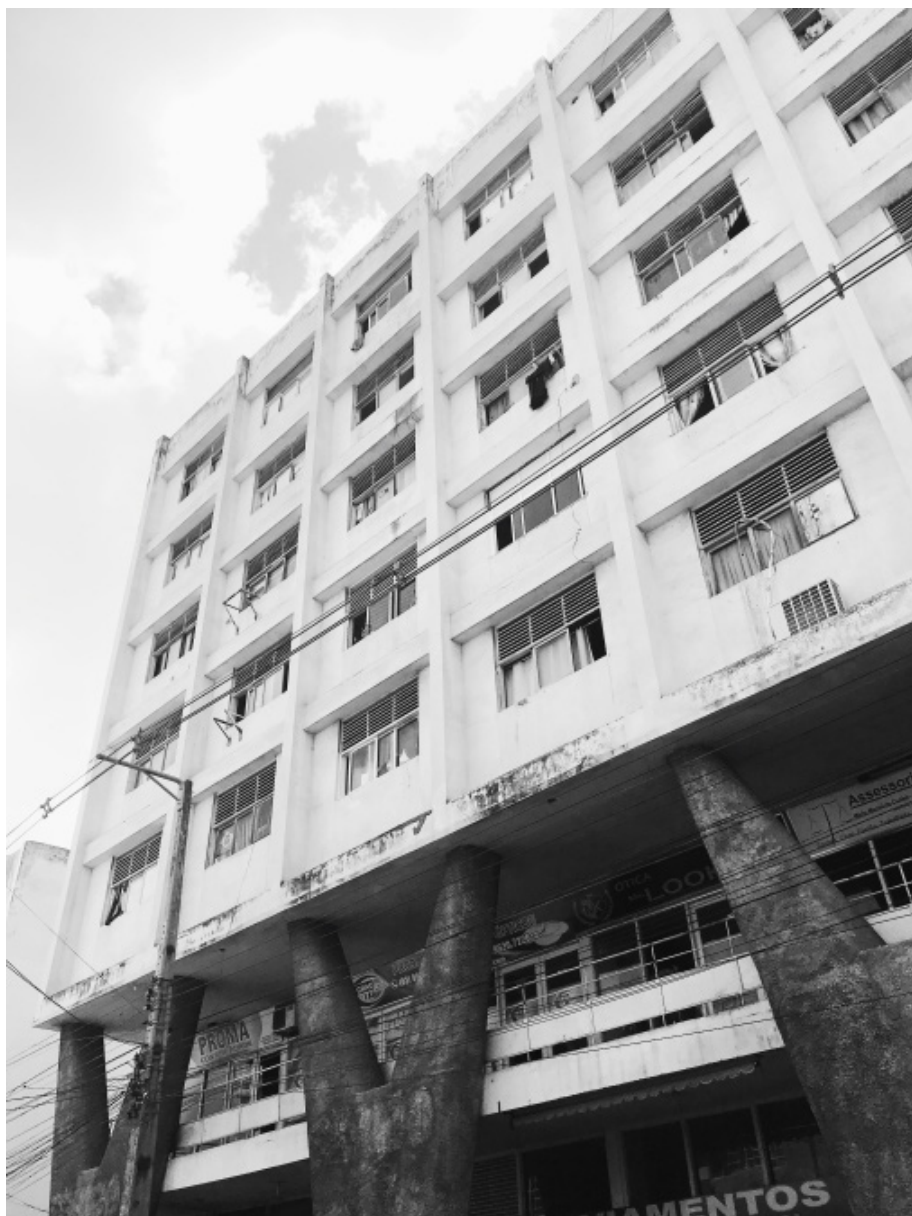
Edifício Prata, rua Semeão Leal. Projeto: Lynaldo Cavalcanti, 1962.
