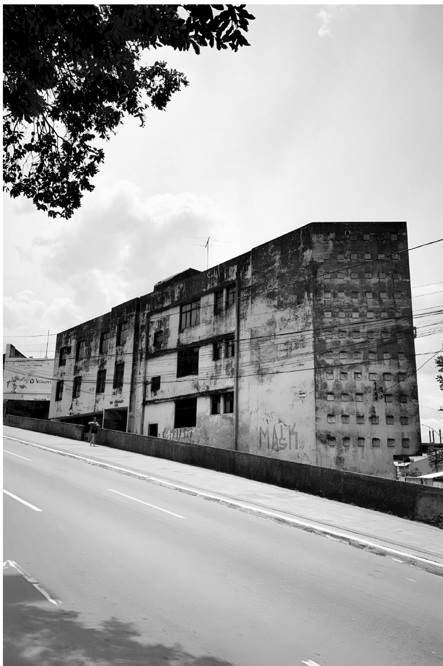
Edifício Alvorada, av. Mal. Floriano Peixoto e rua Tavares Cavalcanti. Projeto: Hugo Marques, 1962.
