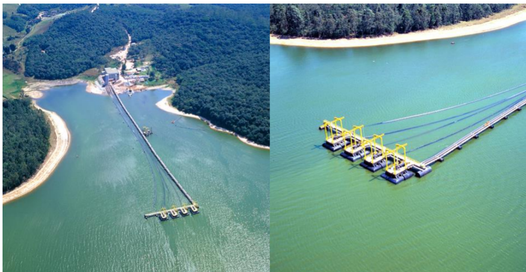
(a) Estrutura de captação flutuante
