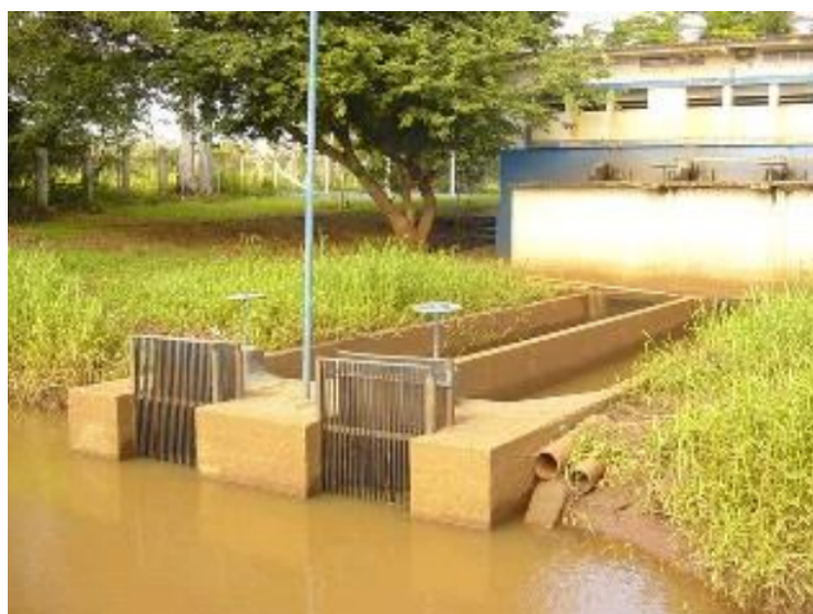
(c) Estrutura de captação utilizando técnica de gradeamento
