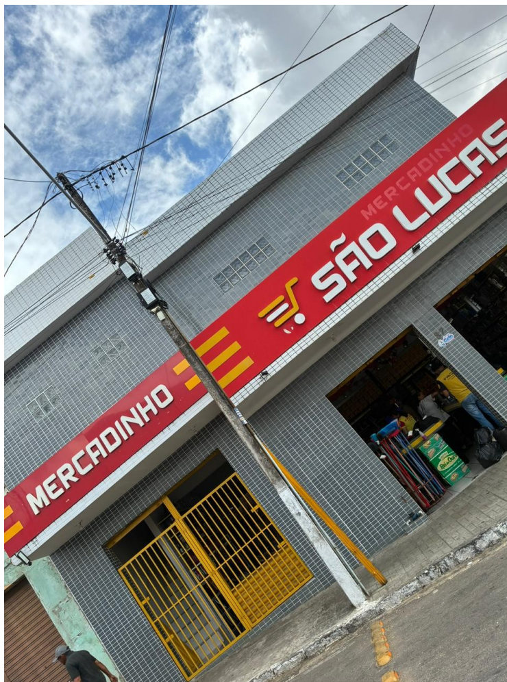
Figura C1 – Entrada do estabelecimento
