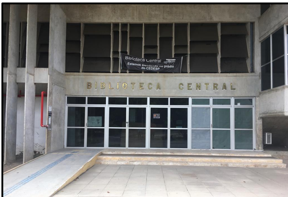
Figura 4 – Fachada da Biblioteca (em reforma)
