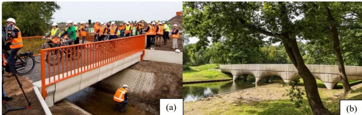
Figura 1 – Ponte de concreto impressa em 3D: (a) em Gemert, (b) em Nijmegen, nos Países Baixos.
