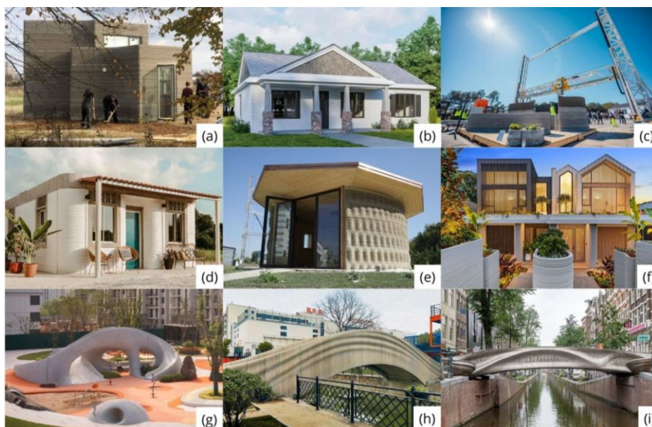
Figura 3 – Exemplos de aplicação de 3DCP
