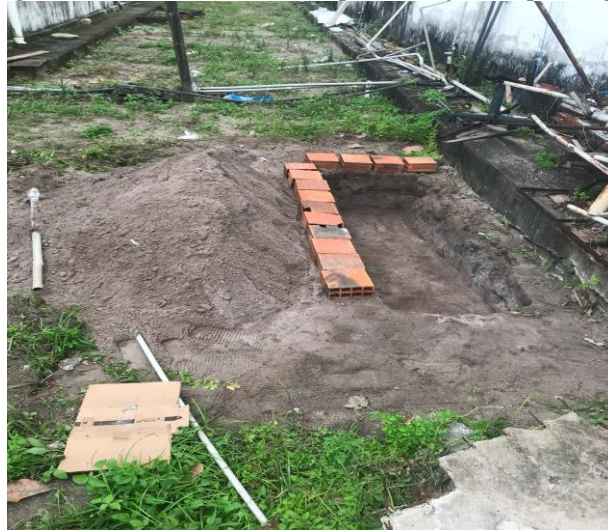
Figura 17- Local selecionado para fixação do protótipo
