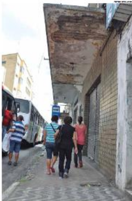
Marquises em péssimas condições oferecem riscos e causam medo à população da capital
