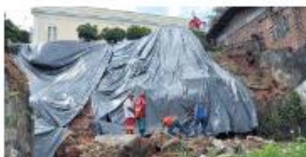
Trabalhos de manutenção em um prédio antigo em João Pessoa
