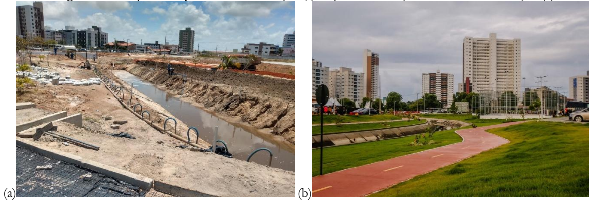
Figura 6 – Parque Parahyba III em construção (a) e após a finalização da obra de construção (b).
