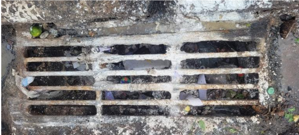
Figura 45. Registros fotográficos da situação atual das grelhas e bocas de lobo no Mercado da Torre.
