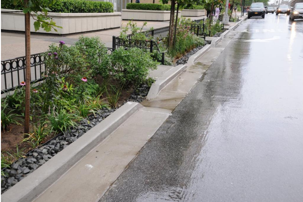
Figura 39. Canteiro pluvial utilizado em via asfaltada para auxiliar no escoamento superficial.
