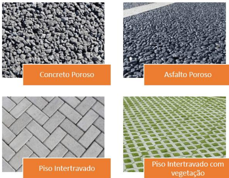
Figura 38. Tipos de pavimentos permeáveis.
