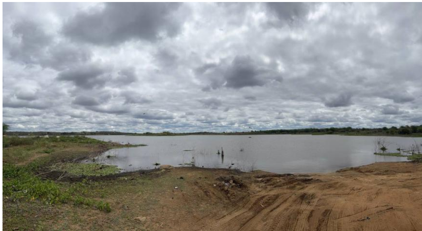
Figura 22 - Açude de Sumé (PB) evidenciando redução do volume armazenado.
