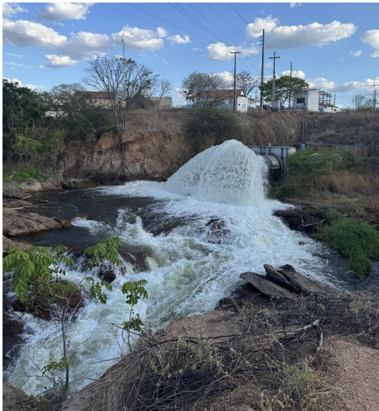
Figura 15 - Descarga de água da Transposição do Rio São Francisco, em Sousa (PB).
