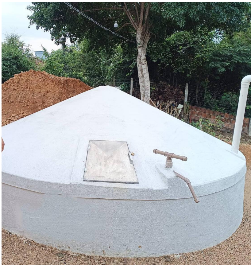
Figura 6 - Cisterna utilizada para armazenamento de água, como estratégia de convivência com o semiárido, em Picuí (PB).
