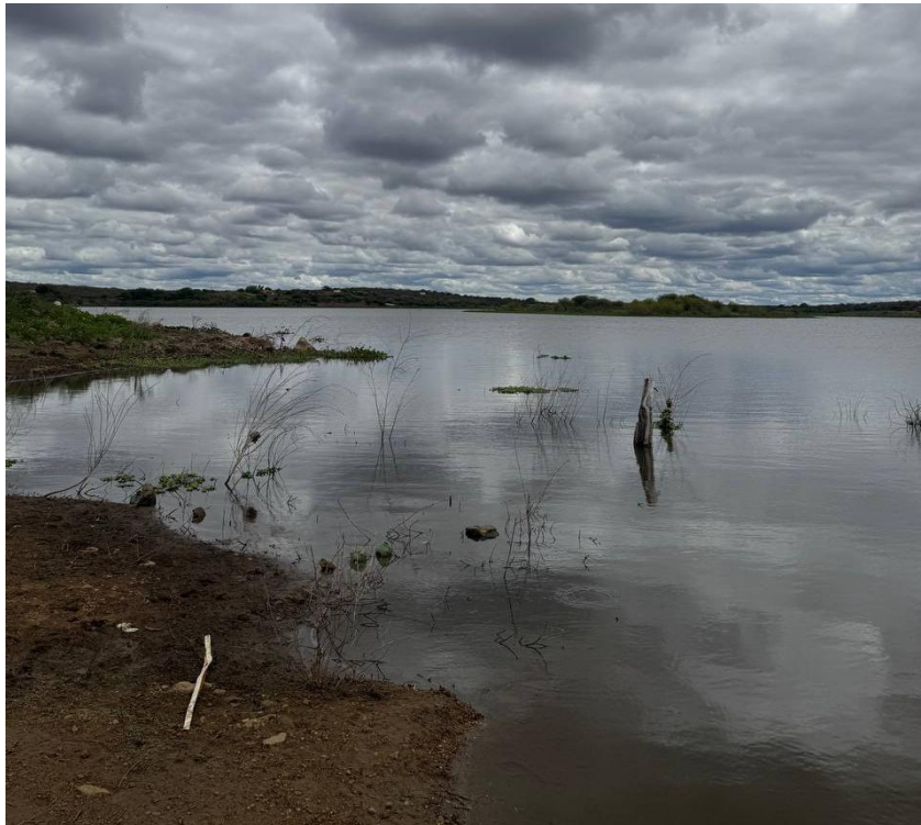
Figura 23 - Açude de Sumé (PB) evidenciando redução do volume armazenado.
