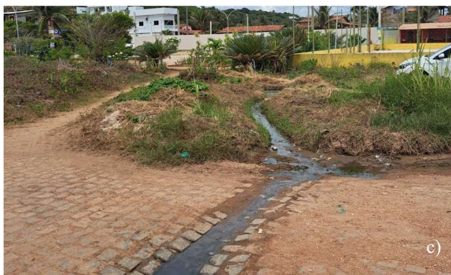
(c) Infiltração em solo exposto.
