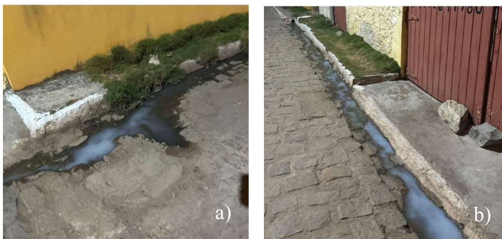
(a) Escoamento em calçada.
