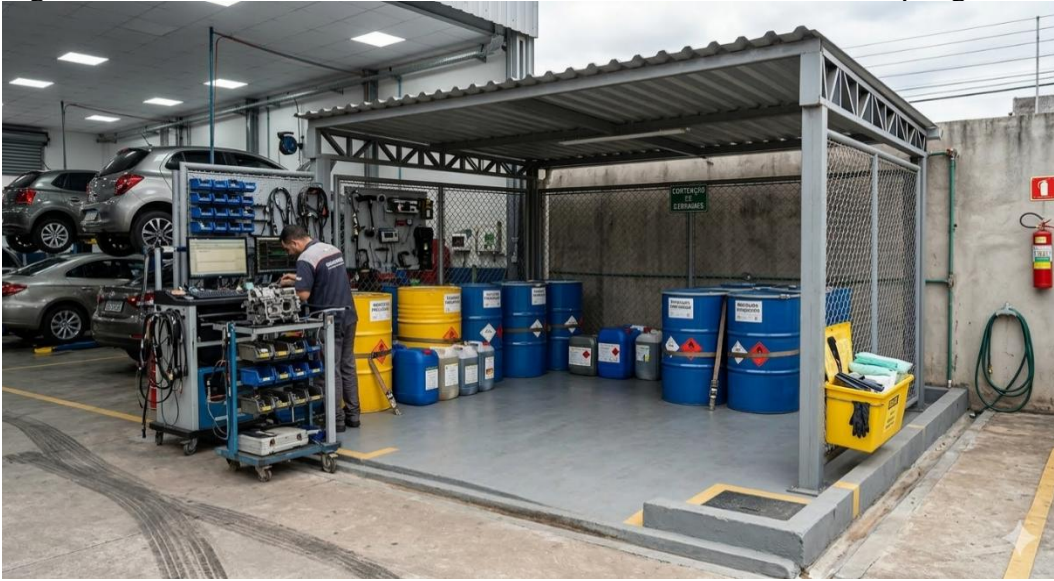
Figura 2 - Área destinada ao armazenamento de tambores de resíduos perigosos
