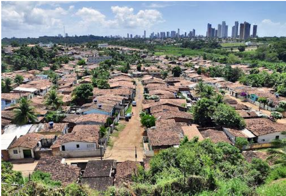
Figura 32 - Edificações na comunidade do Timbó, antes da pavimentação de todas as ruas
