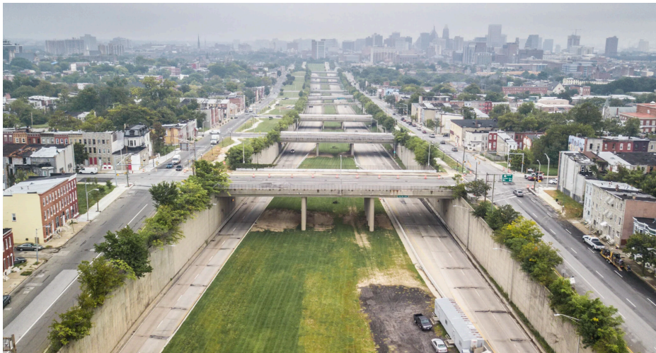
Figura 03 - Pontes rodoviárias ligando diferentes setores
