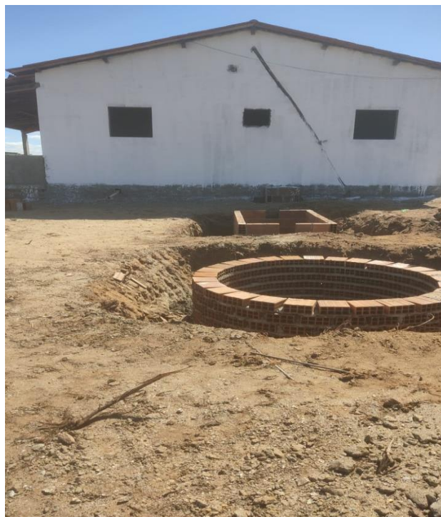
Figura 13 - Construção de fossa séptica e sumidouro
