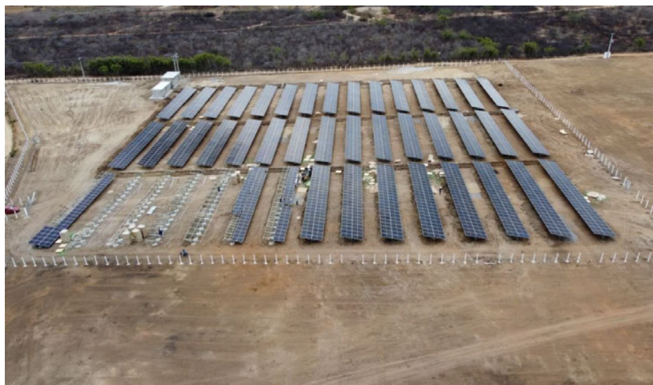
Figura 16 - Fase final da instalação da usina
