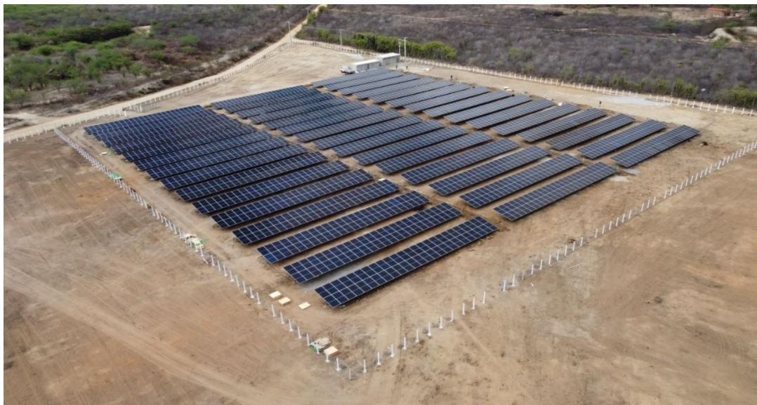
Figura 17 - Conclusão da instalação da usina
