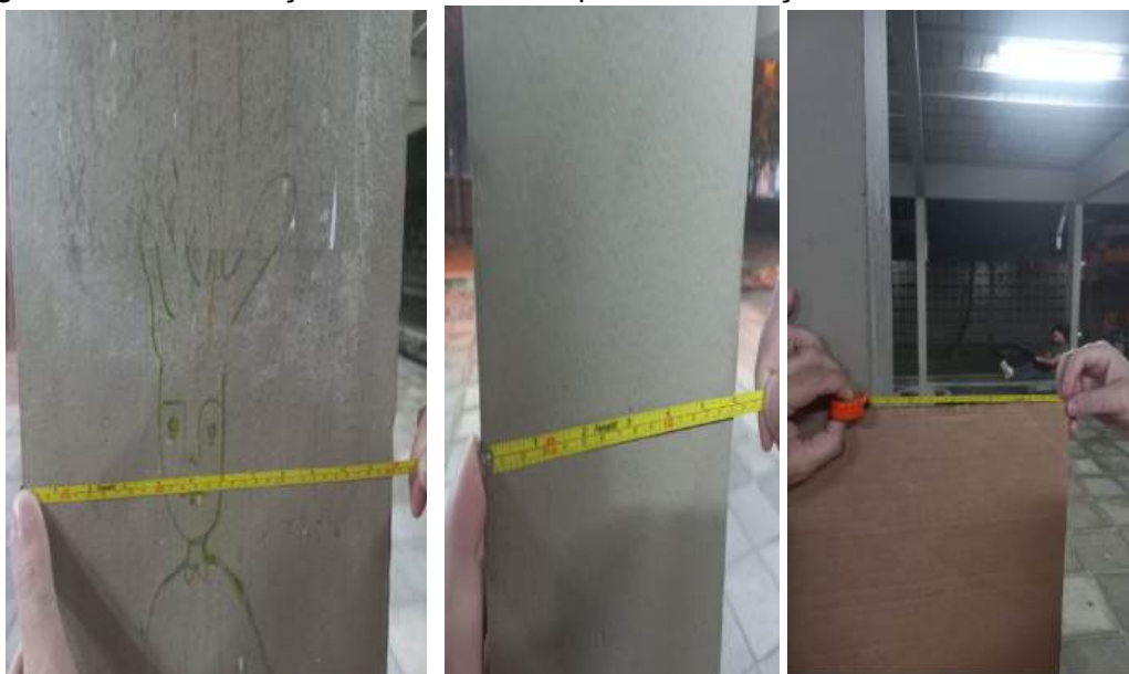
Figuras 6, 7, 8 – Medições realizadas nos pilares da Praça Alberto Torres no CCSA.
