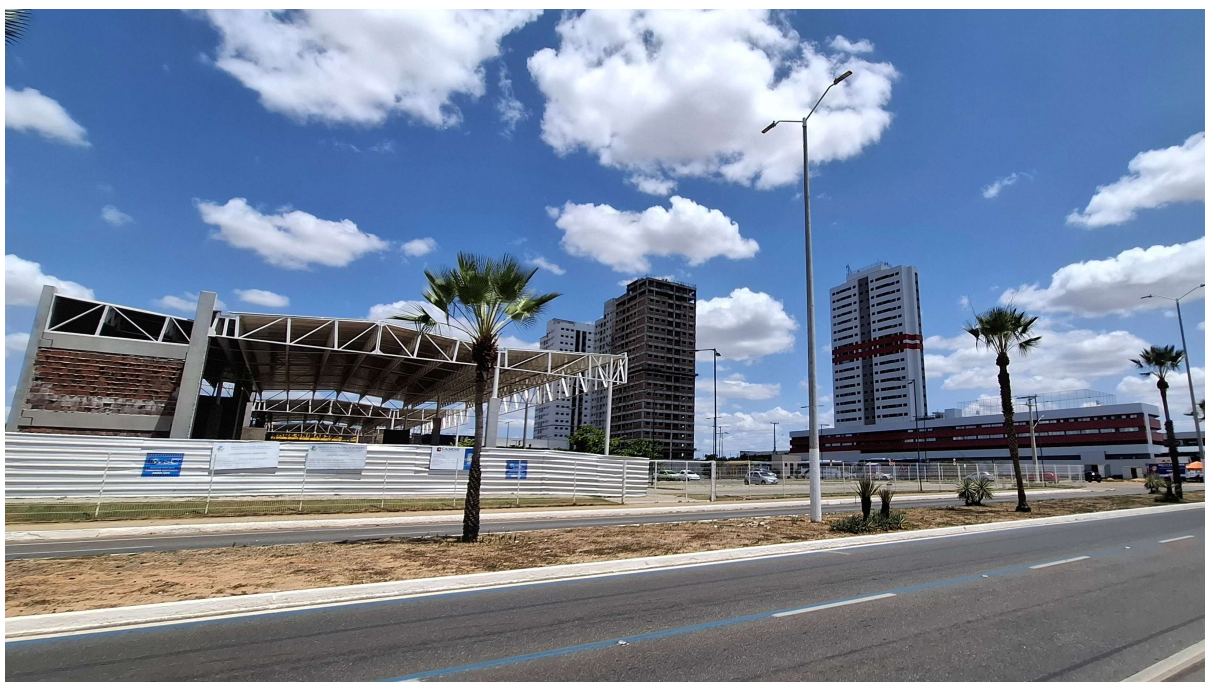
Figura 68 - UNINASSAU (esquerda), Palazzo Residence (centro) e WHB (direita)
