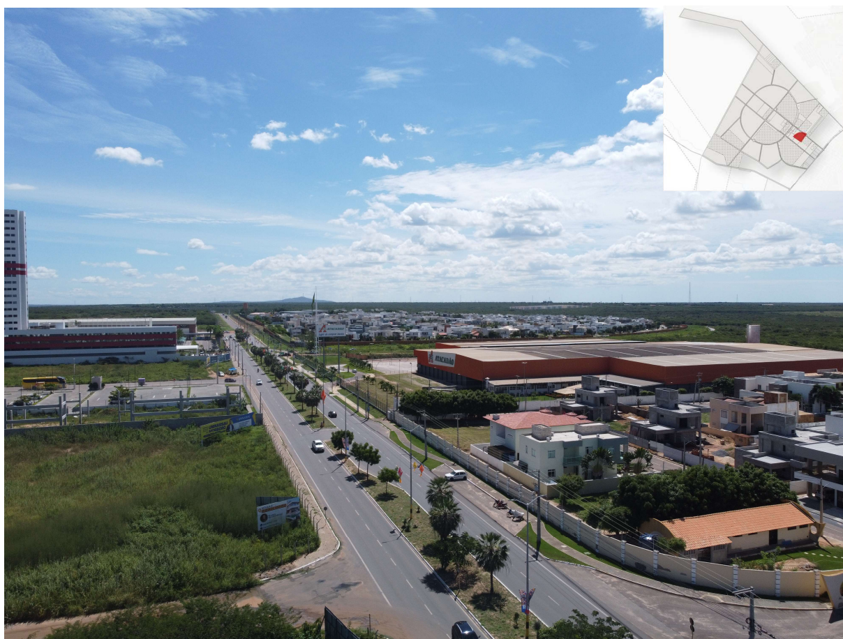
Figura 57 – Imagem aérea do Atacadão Mossoró (fachada laranja)
