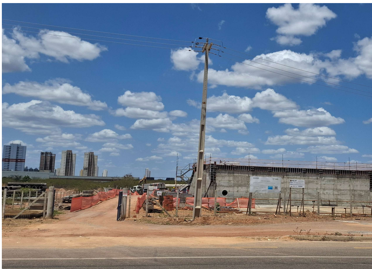
Figura 65 – Reservatório da CAERN
