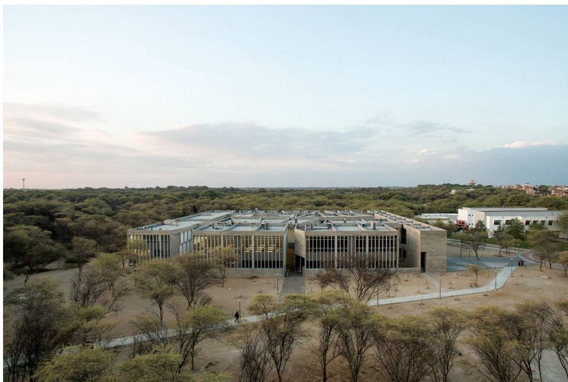
FIGURA 30 - EDIFÍCIO E, UNIVERSIDADE DE PIURA
