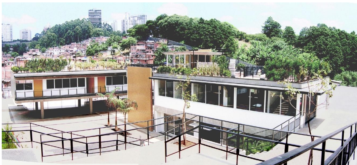
FIGURA 09 - EDIFÍCIO PROJETO VIVER
