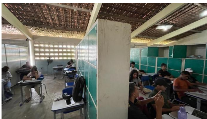
Figura 7. Salas de aula improvisadas durante a reforma.
