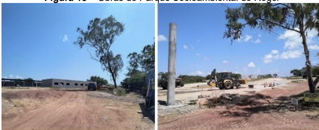
Figura 18 – Obras do Parque Socioambiental do Roger
