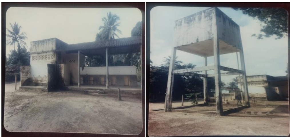
Figura 3 - Prédio onde ficavam o banheiro público, chafariz e lavanderias.
