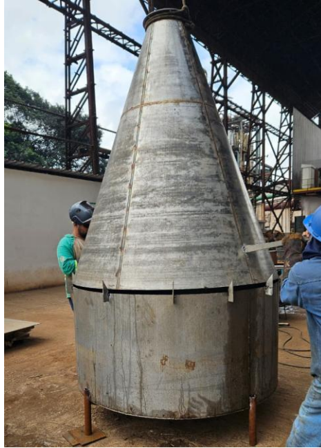
Figura 5 – Estrutura metálica em formato de cone sendo montada em campo.
