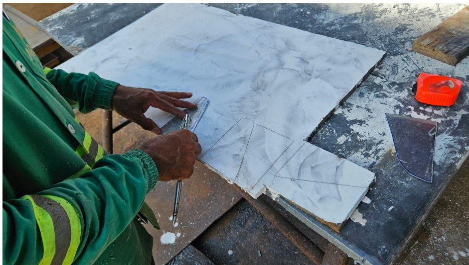
Figura 3 – Marcação de gabarito em placa para corte.
