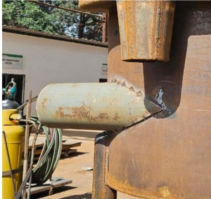
Figura 7 – Estrutura metálica em processo de fabricação com destaque para a boca de lobo.
