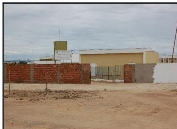
Figura 13 - Início das obras do campus do IFCE de Crateús em 2008
