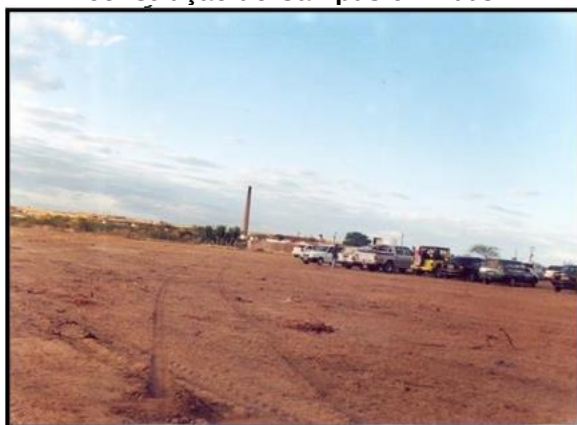
Figura 12 - Terraplanagem do local de construção do Campus em 2008
