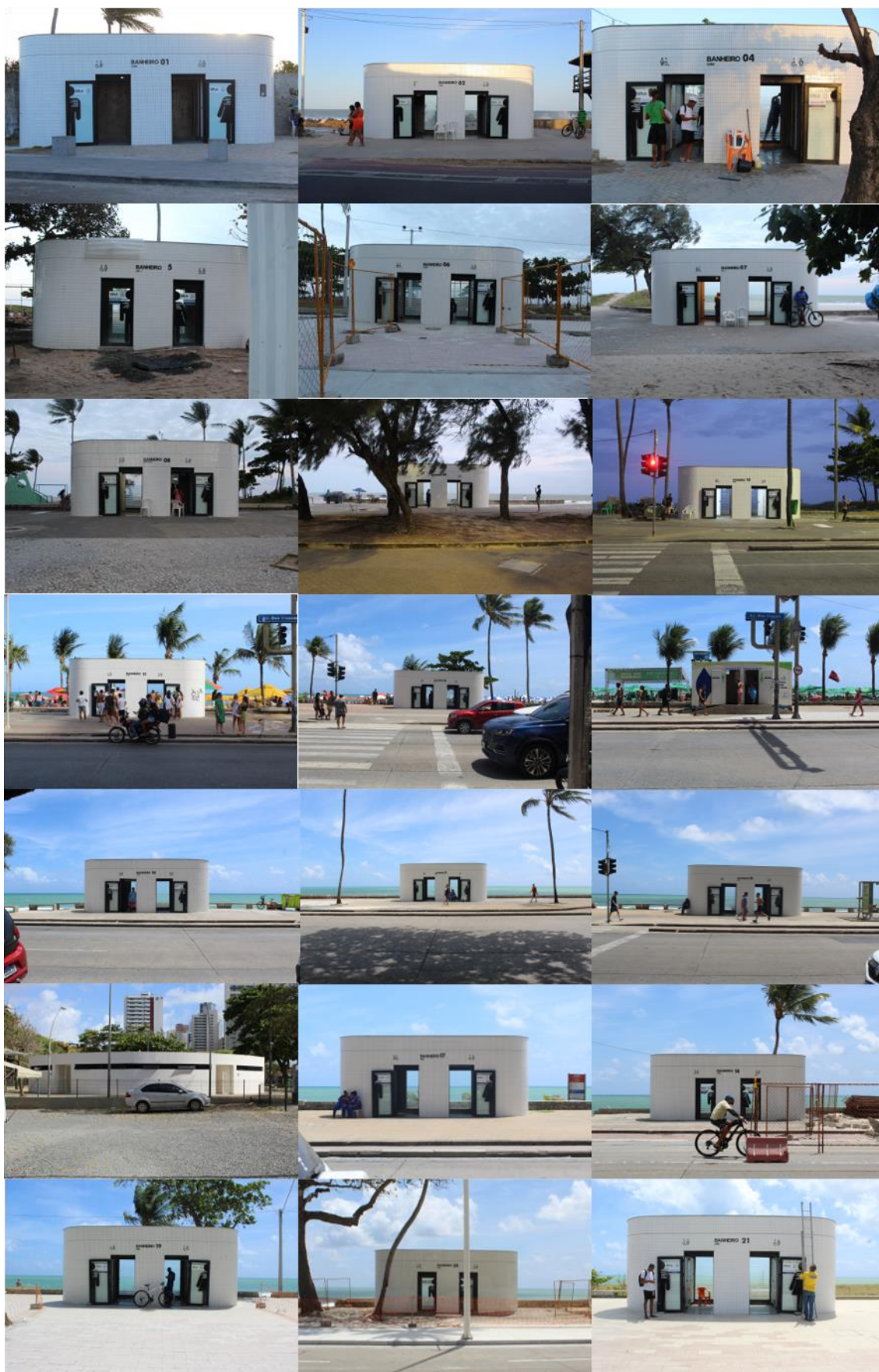
Figura 15. Vista Frontal dos 21 banheiros mapeados na orla de Recife.
