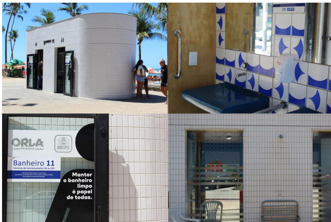
Figura 16. Banheiro público da orla de Recife, vista externa e interna do equipamento urbano.
