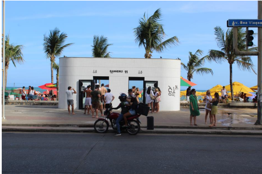
Figura 30. Contexto de localização do banheiro B11, na praia de Boa Viagem
